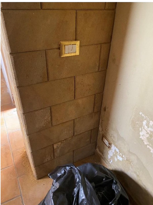
Vista del degrado sulle pareti e in prossimità delle prese impianto elettrico
