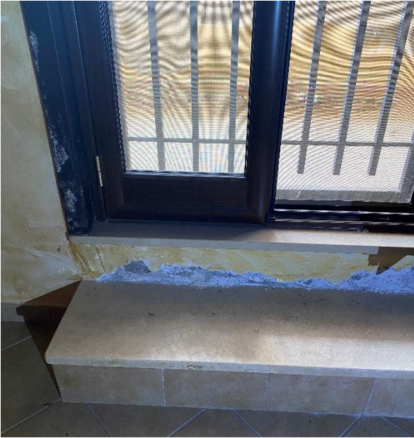
Vista del degrado e corrosione degli imbotti degli infissi in alluminio
