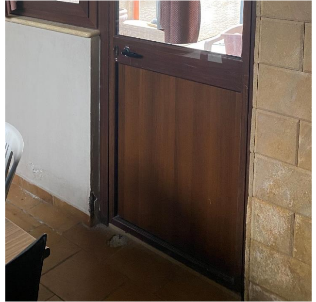
Vista del degrado e corrosione degli imbotti degli infissi in alluminio
