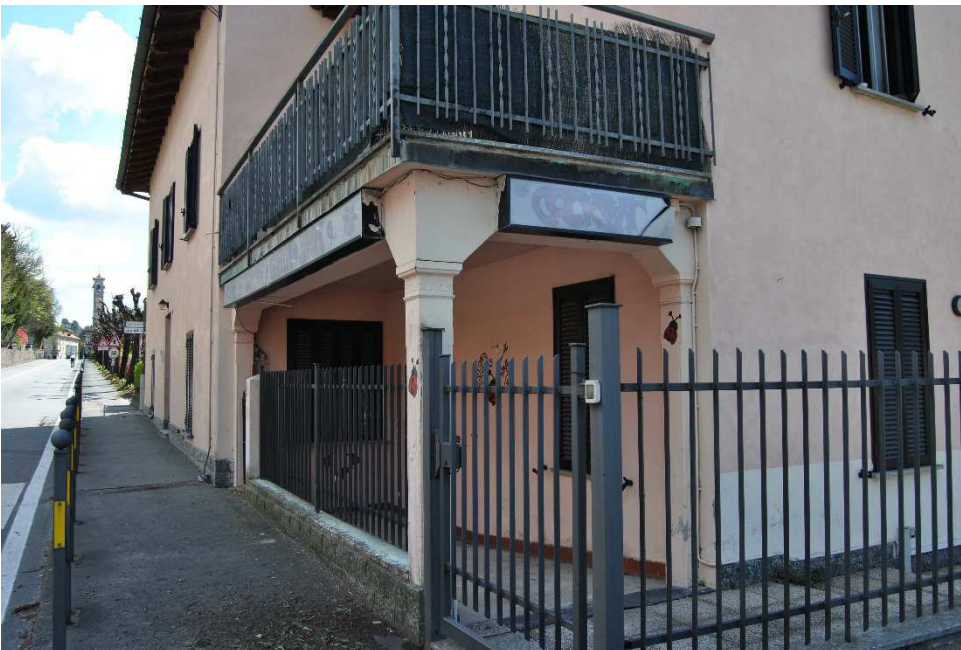
Foto 2 : particolare ingresso esterno
