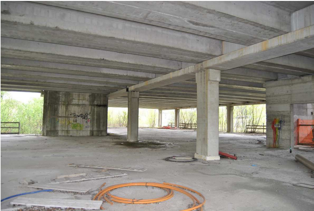
Foto 3 : Particolare piano terra allo stato grezzo
