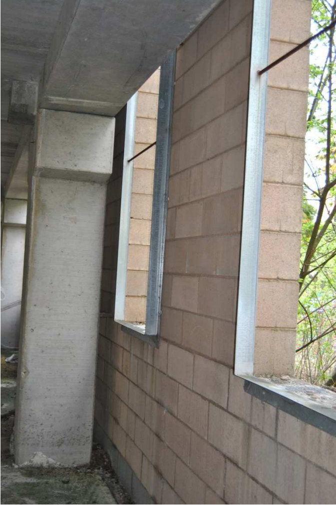
Foto 5 : Particolare tamponamento con blocco facciavista e struttura prefabbricata interna
