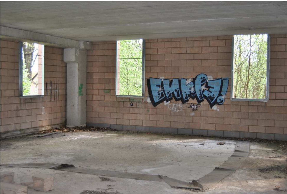
Foto 4 : Particolare tamponamento con blocco facciavista e struttura prefabbricata interna
