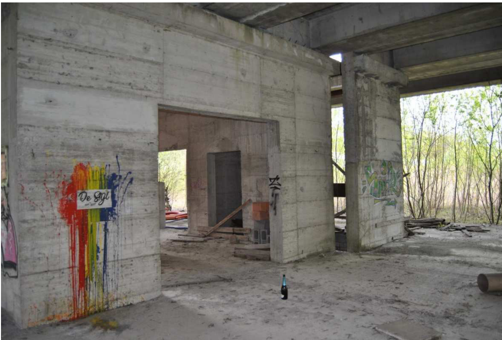
Foto 4 : Particolare piano terra allo stato grezzo
