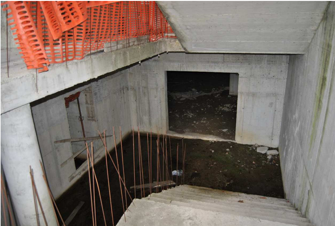
Foto 7 : particolare scala che conduce al piano interrato
