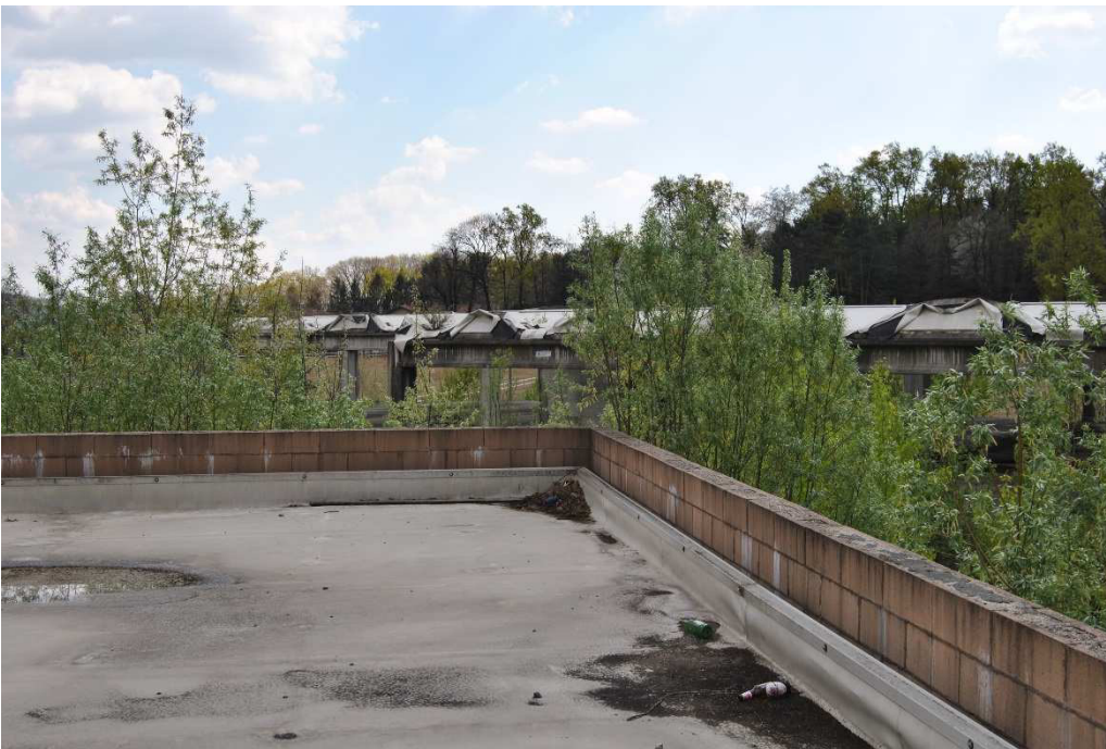
Foto 6 : Particolare copertura piana con guaina
