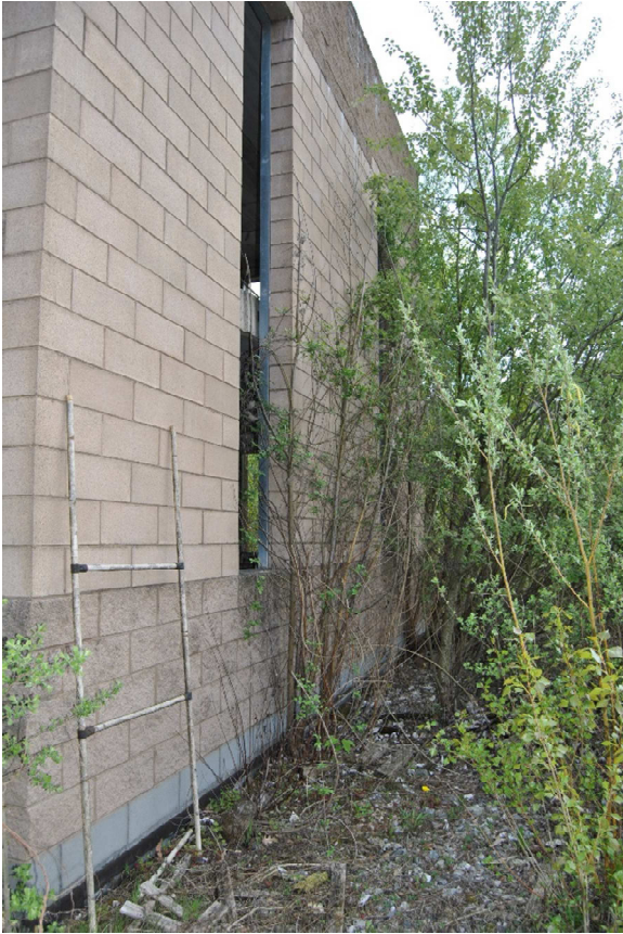
Foto 3 : Particolare tamponamento con blocco facciavista esterno
