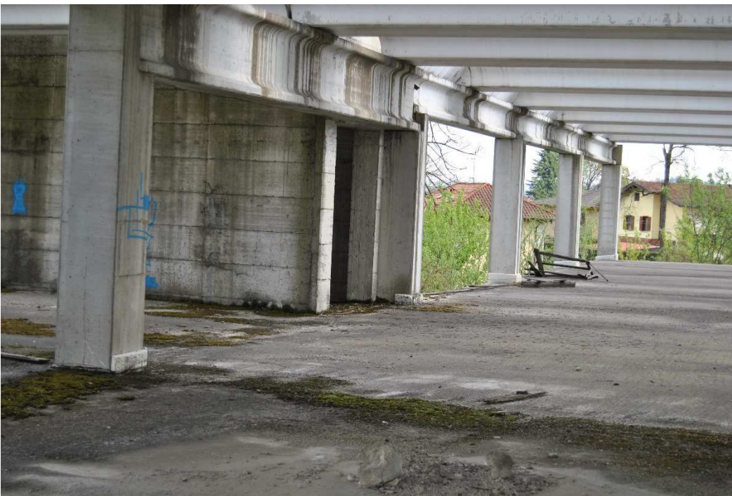
Foto 6 : particolare piano primo allo stato grezzo
