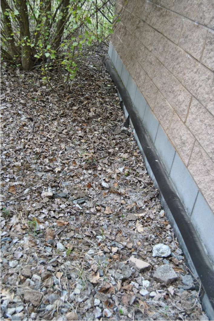
Foto 7 : Particolare guaina e muro a terra
