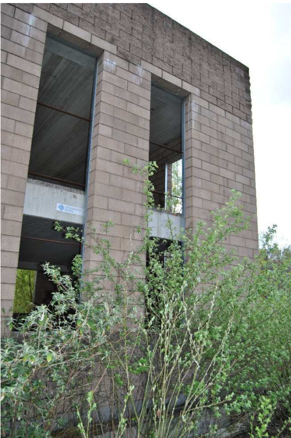
Foto 2 : Particolare facciata esterna della palazzina uffici
