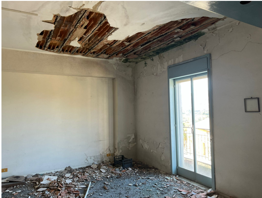
Figura 2 – Interno del LOTTO 9 – affaccio sul ballatoio sulla strada privata
