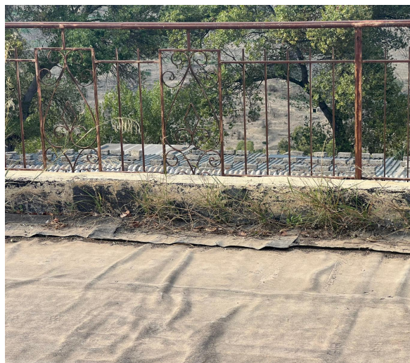
Figura 9 – particolare della guaina sul lastrico solare
