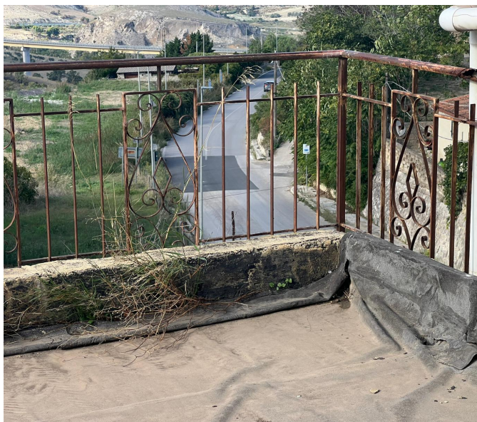
Figura 8 – particolare della guaina sul lastrico solare
