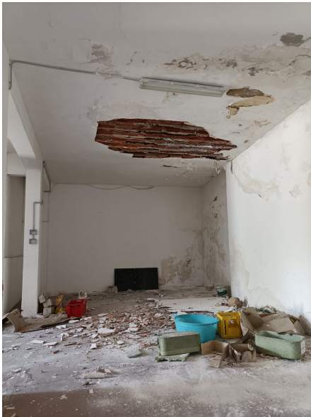
Figura 12 – Immobile sottostante il LOTTO 9
