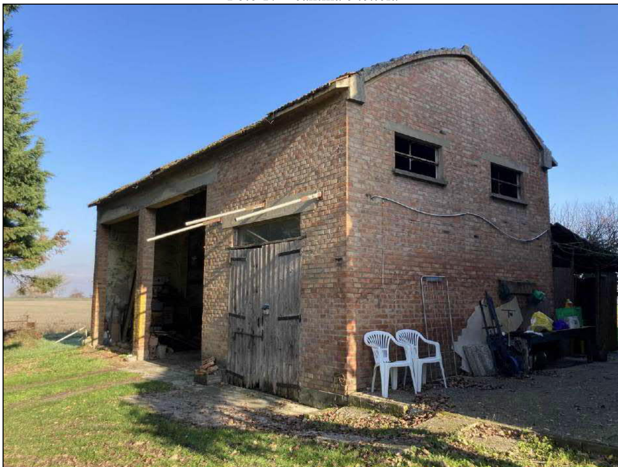
Foto 17 – cantina e tettoia
