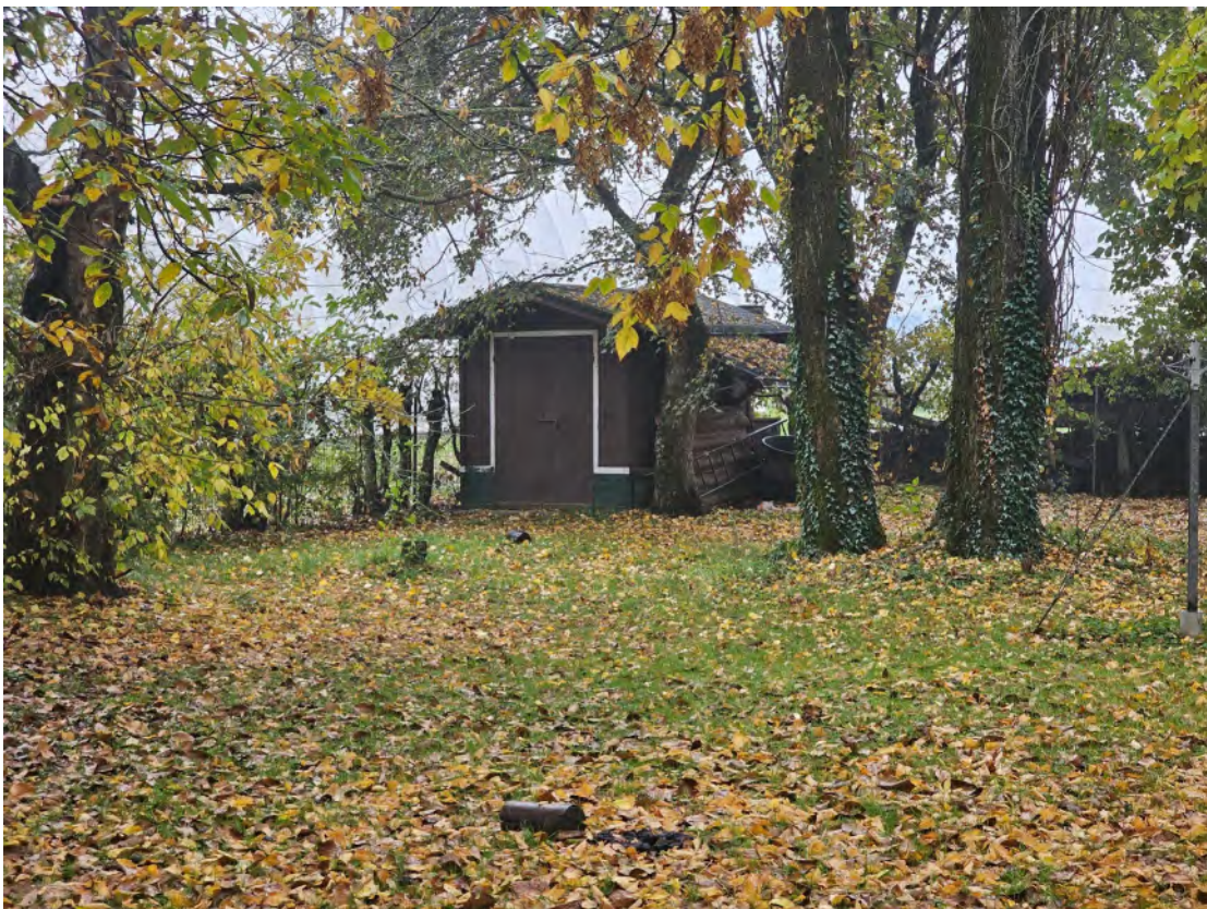
Esterno 8: Area cortiliva – casetta in legno da demolire
