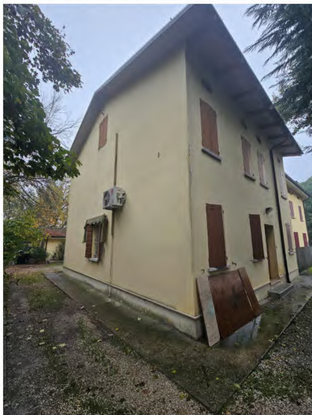
Esterno 2: Fabbricato abitativo – Prospetto Est
