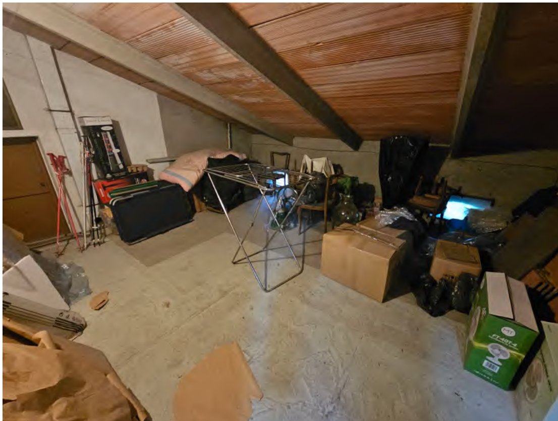
Interno 12: Soffitta – p.secondo sottotetto
