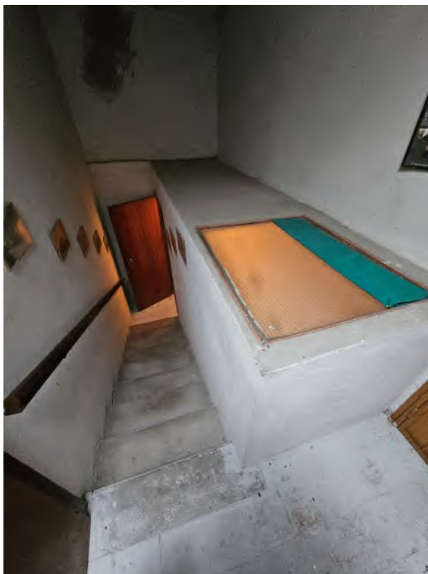
Interno 14: Scala – p.secondo sottotetto
