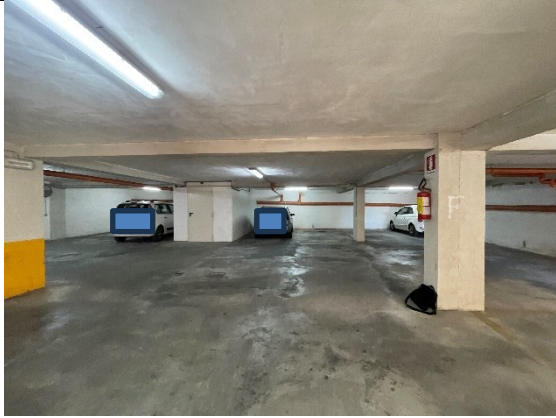
Foto n. 17 Posto auto piano cantinato
