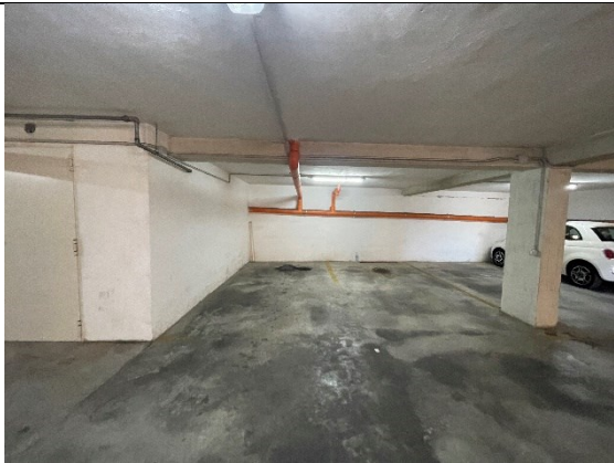
Foto n. 19 Posto auto piano cantinato
