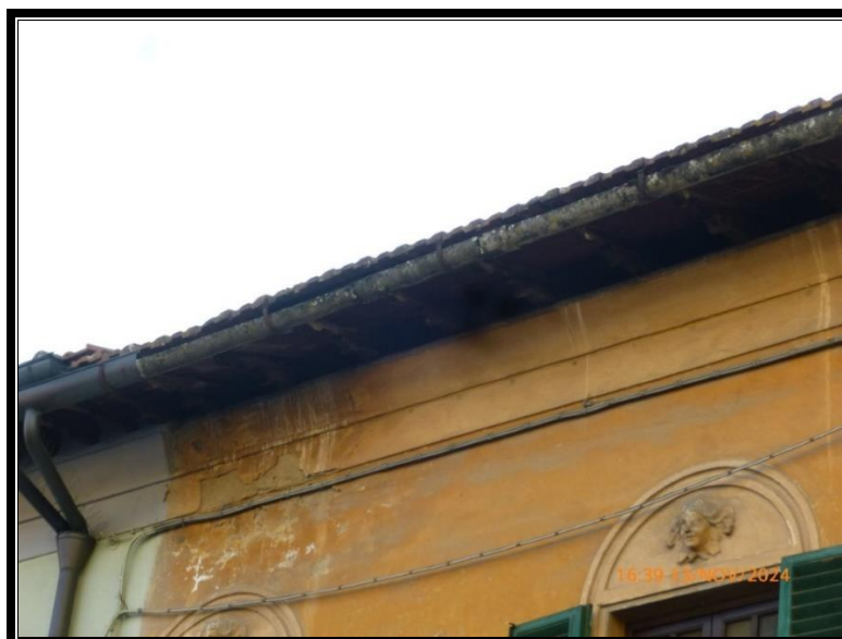
Veduta gronda in pessimo stato facciata principale
