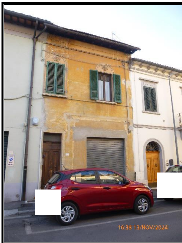
Veduta gronda in pessimo stato facciata principale
