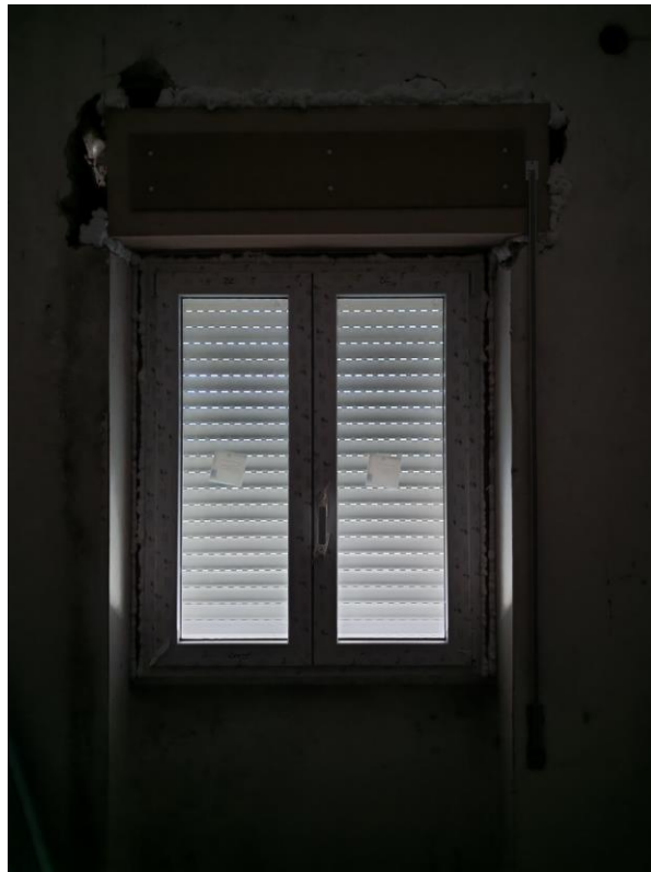
Vista particolare e generale interna del montaggio degli infissi in cui si evince lo stato d'uso e la mancanza delle rifiniture.
