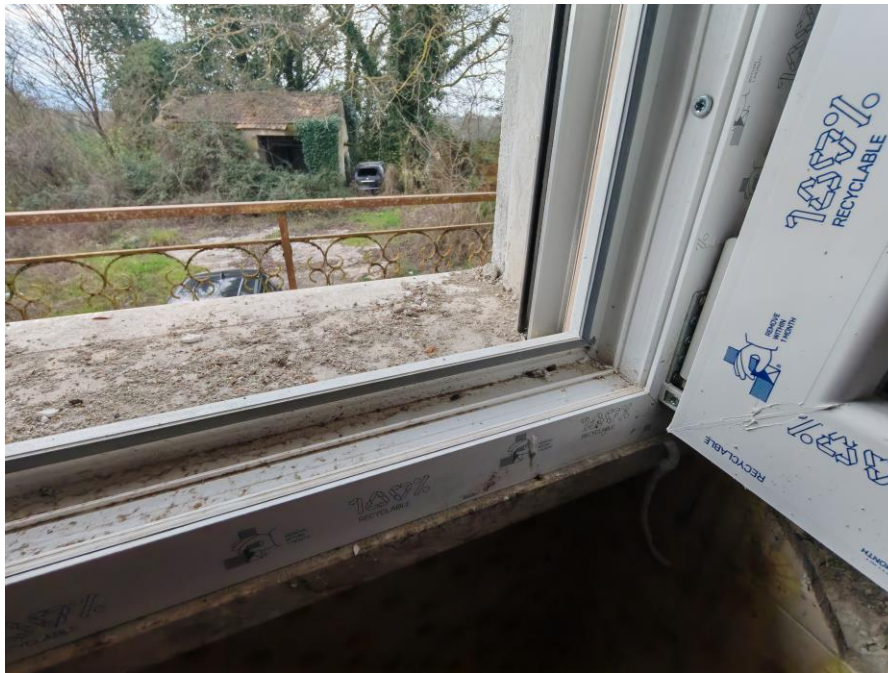
Viste generale e particolare interne del montaggio degli infissi in cui si evince lo stato d'uso e la mancanza delle rifiniture.
