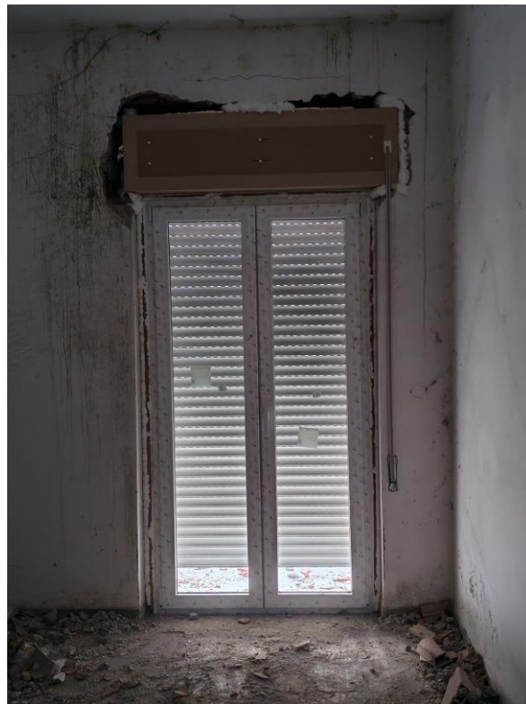
Vista generale interna del montaggio degli infissi in cui si evince lo stato d'uso e la mancanza delle rifiniture.
