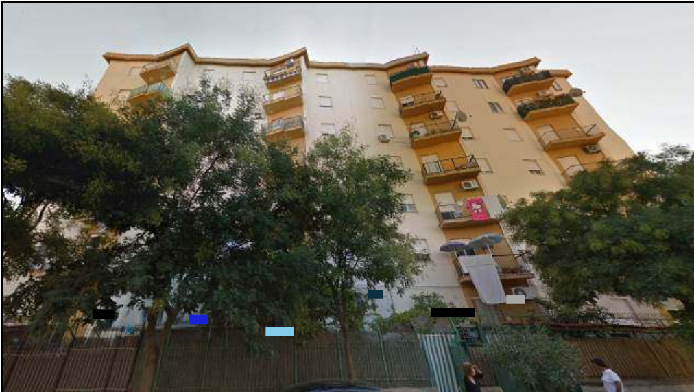
Prospetto su via Pisano
