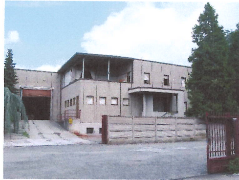
Vista dalla strada privata
