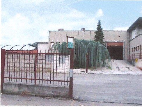
Vista dalla strada privata
