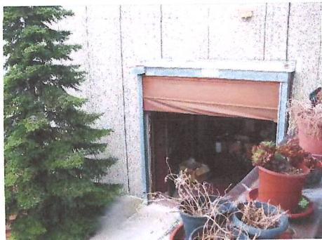
Foto 9 – Vista ingr. interrato
