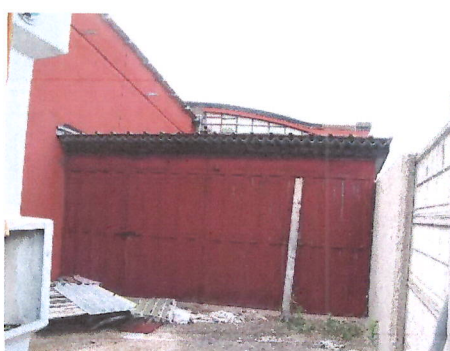
Foto 8 – Vista fabbricato accessorio
