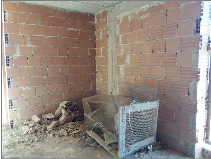
Foto B-5: Interno appartamento allo stato rustico
