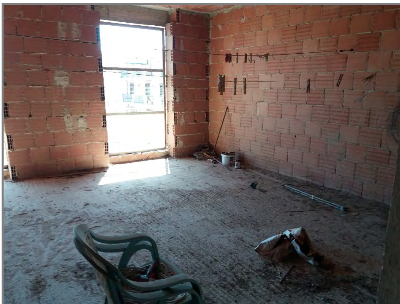
Foto B-3: Interno appartamento allo stato rustico
