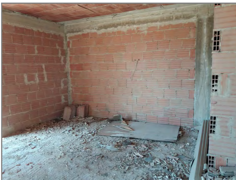
Foto B-4: Interno appartamento allo stato rustico
