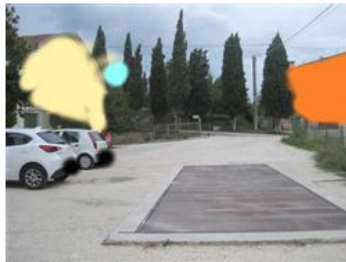
Piazzale d'ingresso veicoli
