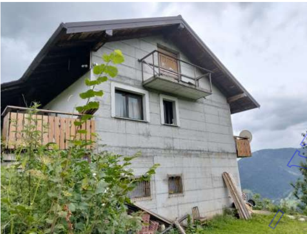
Vista retro lato nord
