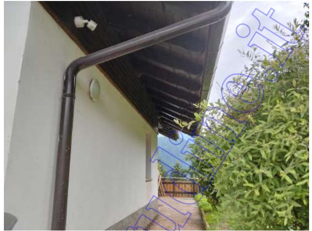
Vista fronte laterale lato est
