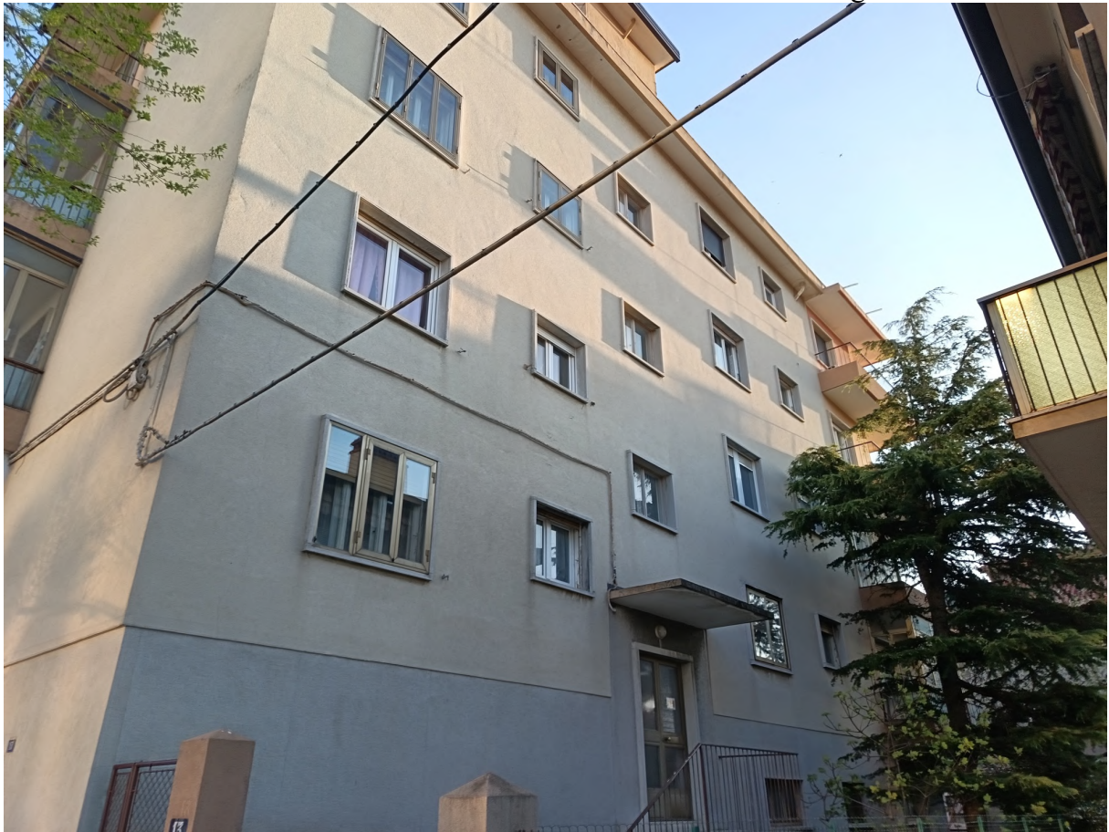
FOTO 2 – facciate stabile civ. 13 di via Carnaro – lato ingresso
