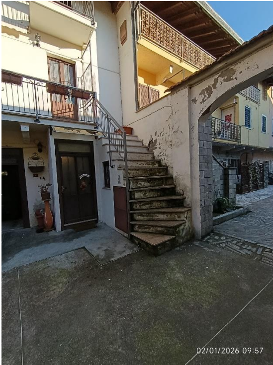
SCALA ESTERNA PER ACCESSO AL BALLATOIO DEL PIANO PRIMO
