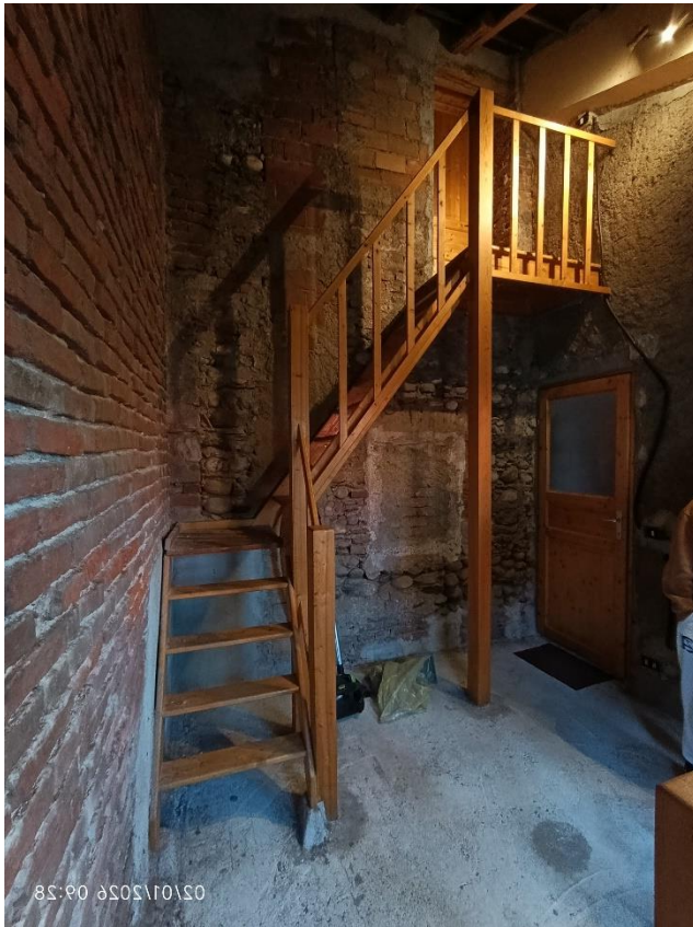
SCALA INTERNA COLLEGAMENTO PIANI PRIMO – SOTTOTETTO.
