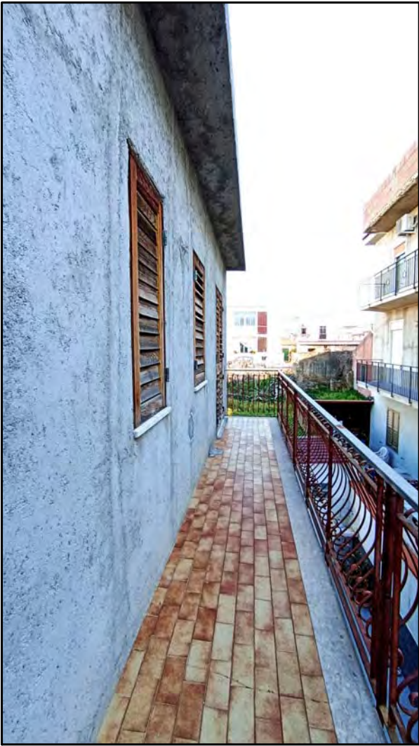
Balcone sul prospetto laterale
