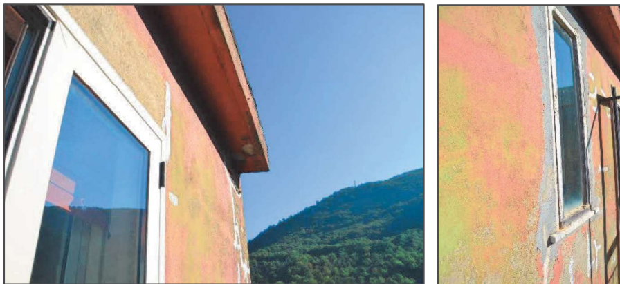
Figura 7 - Vista di insieme del fabbricato
