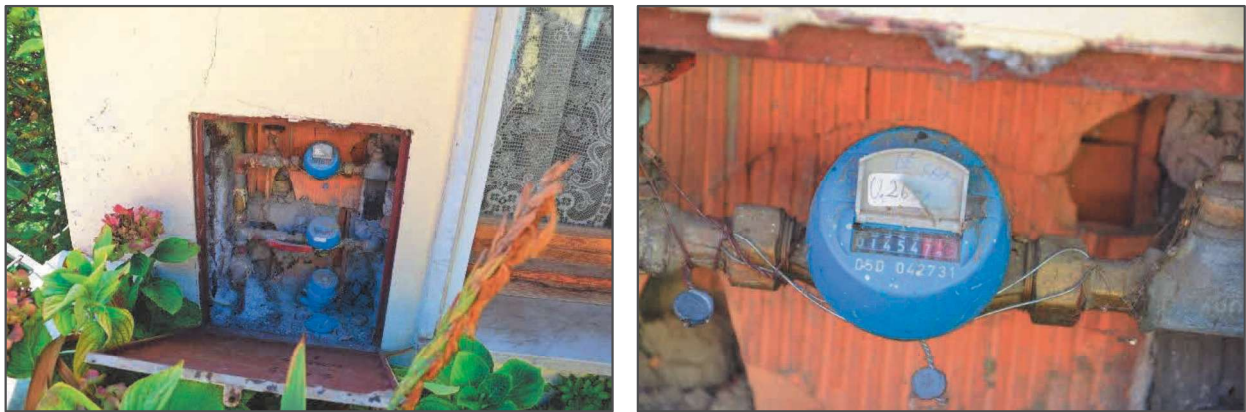
Figura 16 - Contatore idrico
