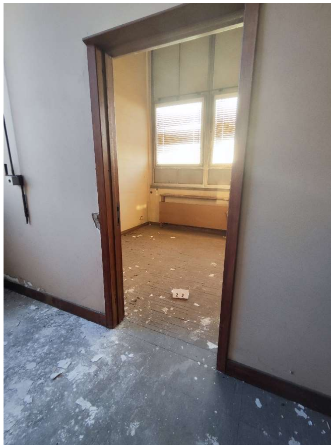
Foto n. 45 – Ingresso ufficio (sub. 762)
