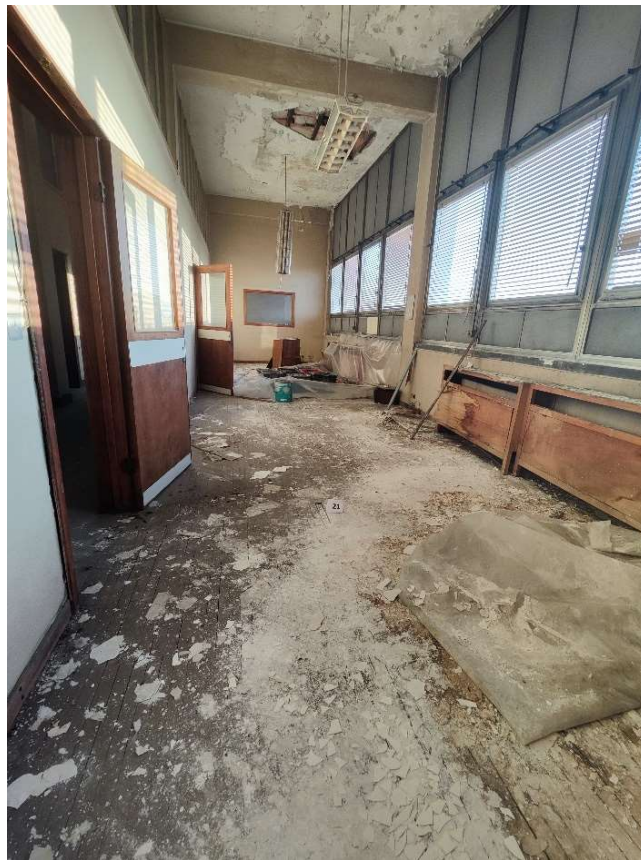
Foto n. 44 – Particolare ufficio (sub 761)
