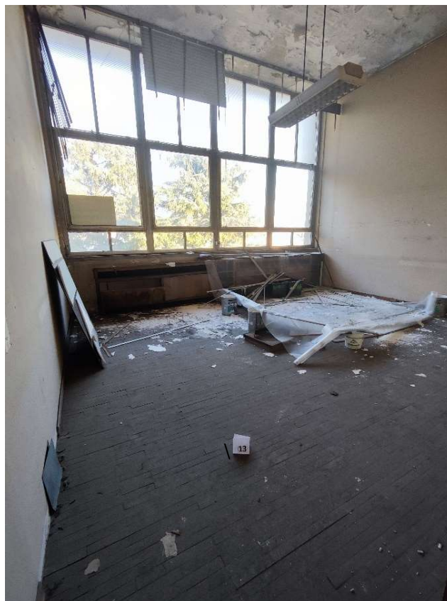
Foto n. 50 – Particolare ufficio (sub 763)
