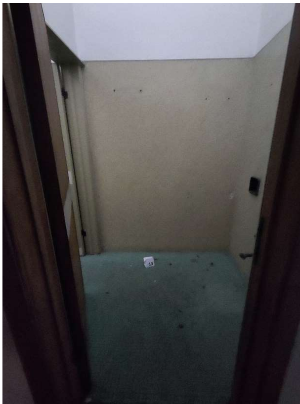
Foto n. 51 – Antibagno ufficio (sub 763)
