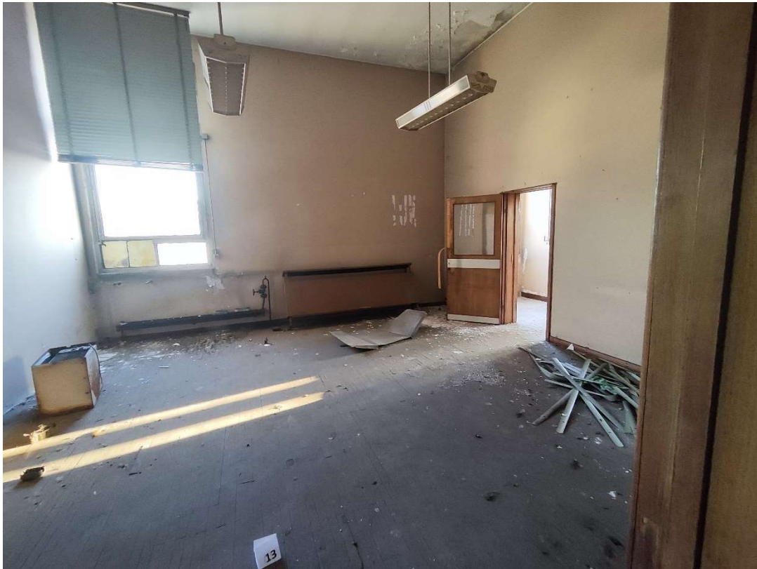
Foto n. 49 – Particolare ufficio (sub 763)
