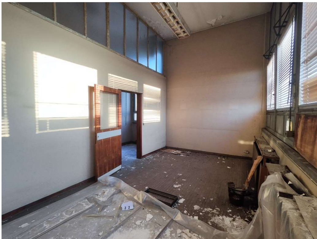
Foto n. 46 – Particolare ufficio (sub 762)
