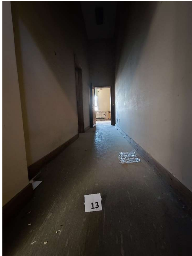
Foto n. 48 – Particolare ufficio (sub 763)
