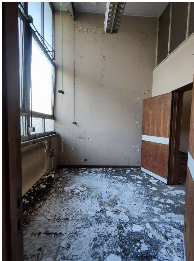
Foto n. 36 – Particolare ufficio (sub 757)
