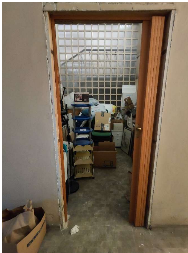
Foto n. 19 – Ingresso all’archivio (sub .753)
