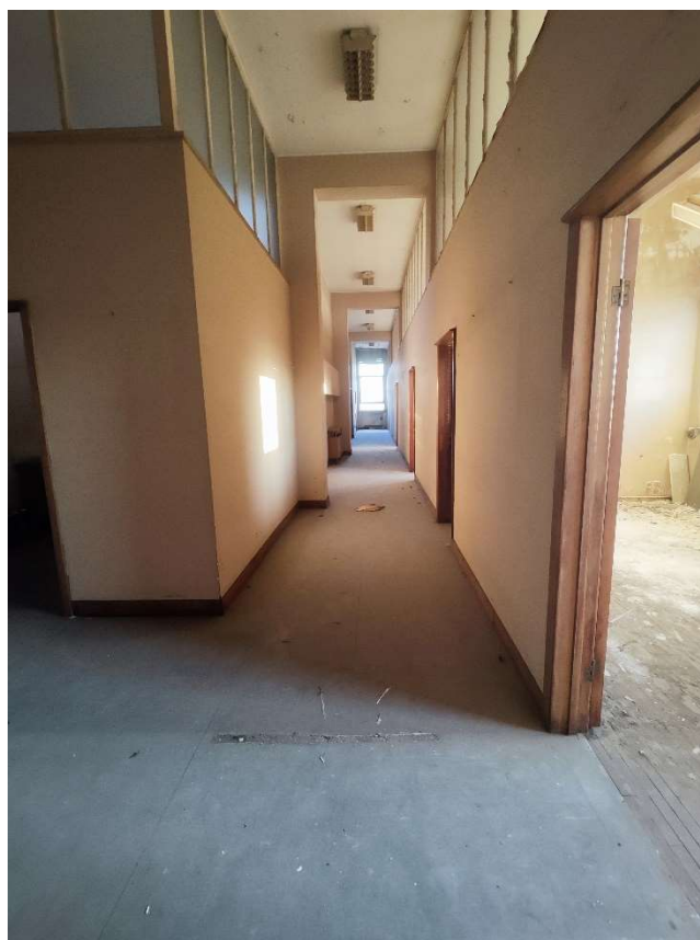
Foto n. 30 – Corridoio piano secondo (sub. 756)
