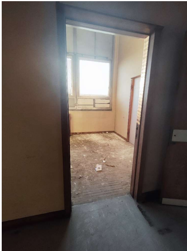
Foto n. 41 – Ingresso ufficio (sub. 760)
