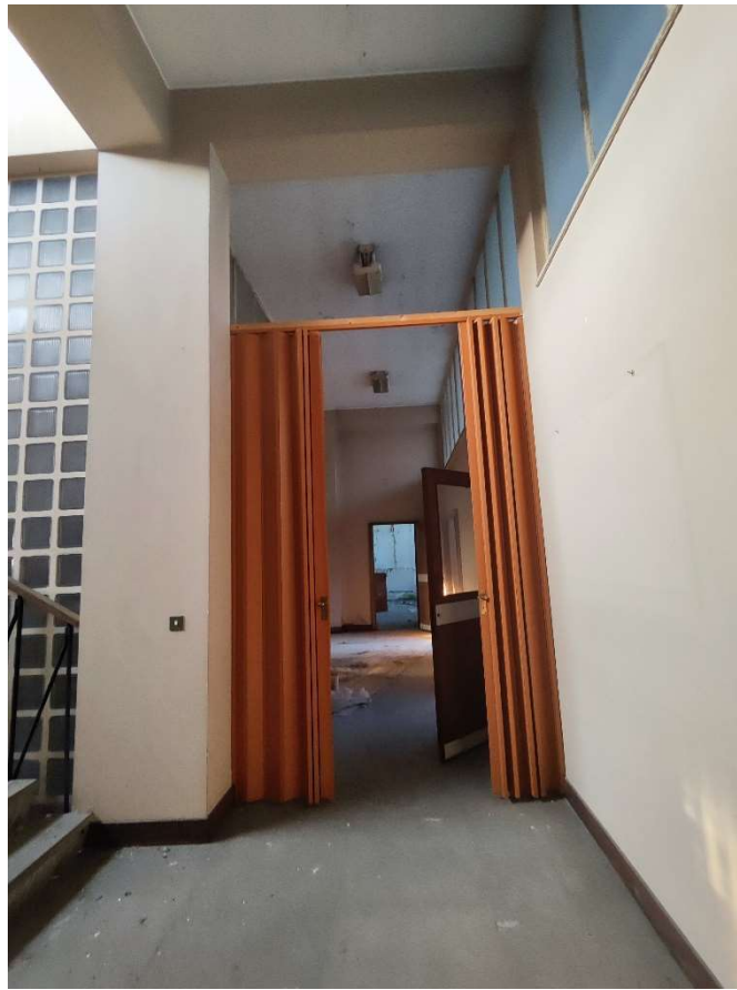
Foto n. 27 – Corridoio piano secondo (sub. 756)
