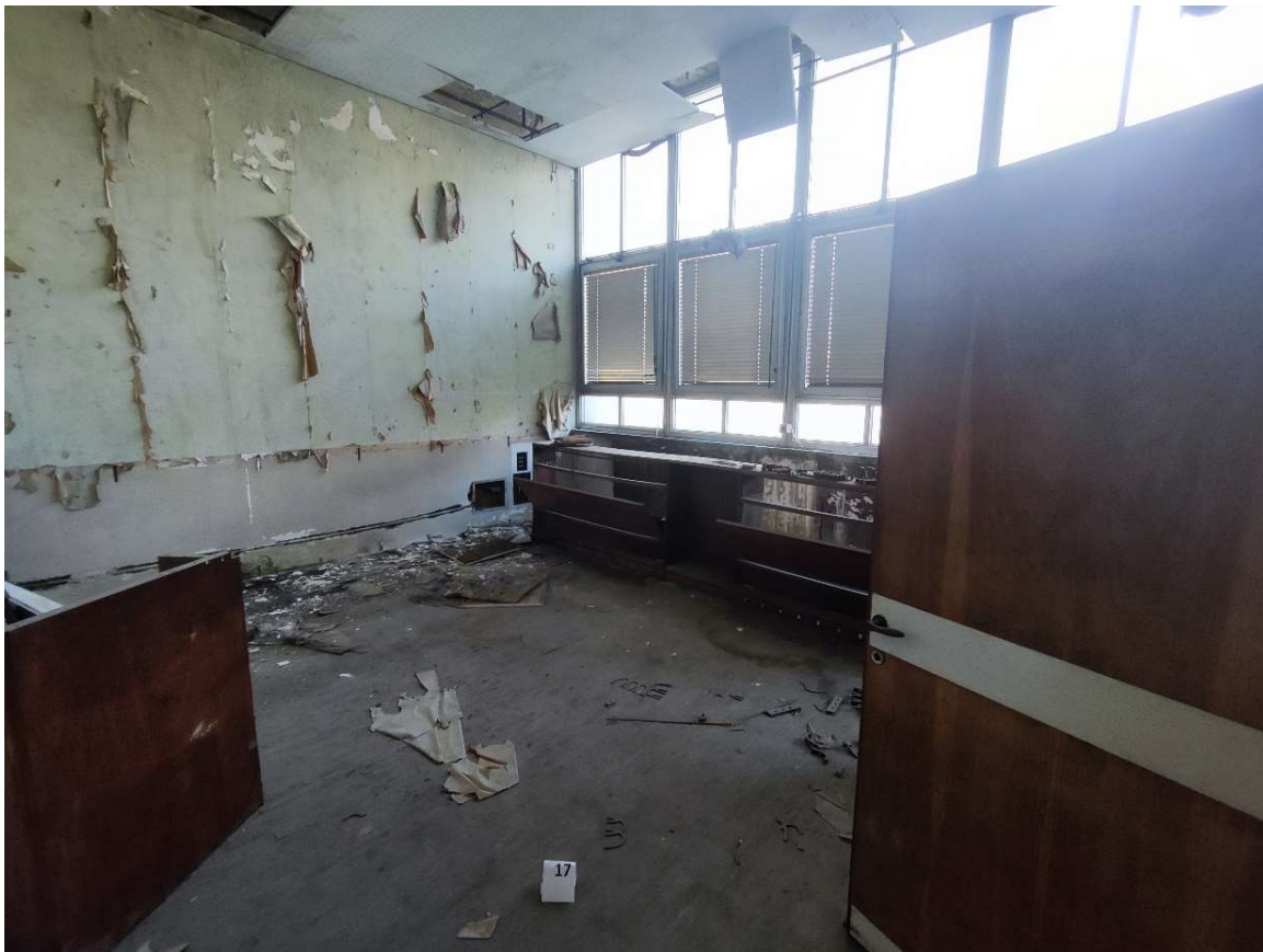
Foto n. 34 – Particolare ufficio (sub 757)
