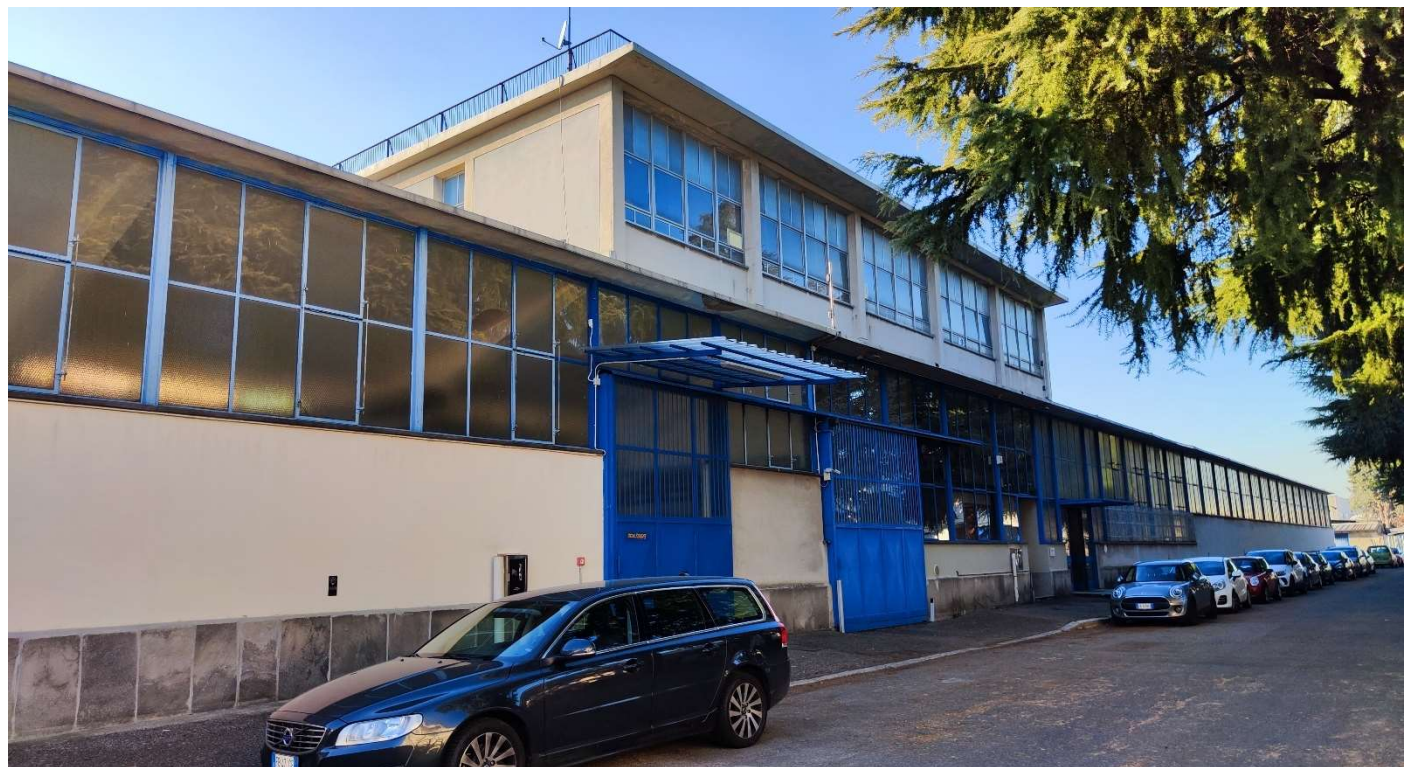
Foto n. 2 – Particolare del fabbricato
