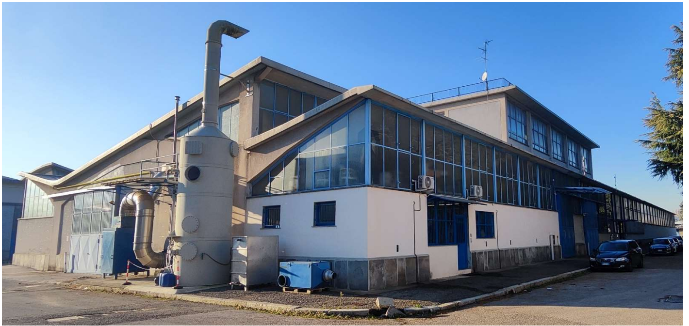
Foto n. 1 – Fabbricato dove si trova il lotto
