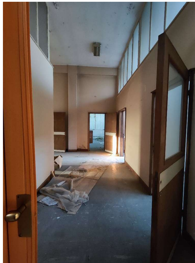
Foto n. 28 – Corridoio piano secondo (sub. 756)
