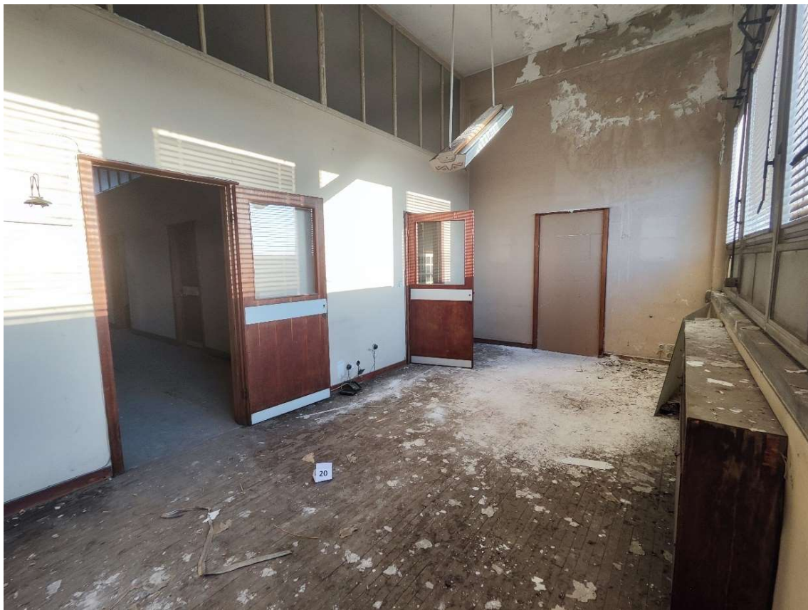
Foto n. 42 – Particolare ufficio (sub 760)
