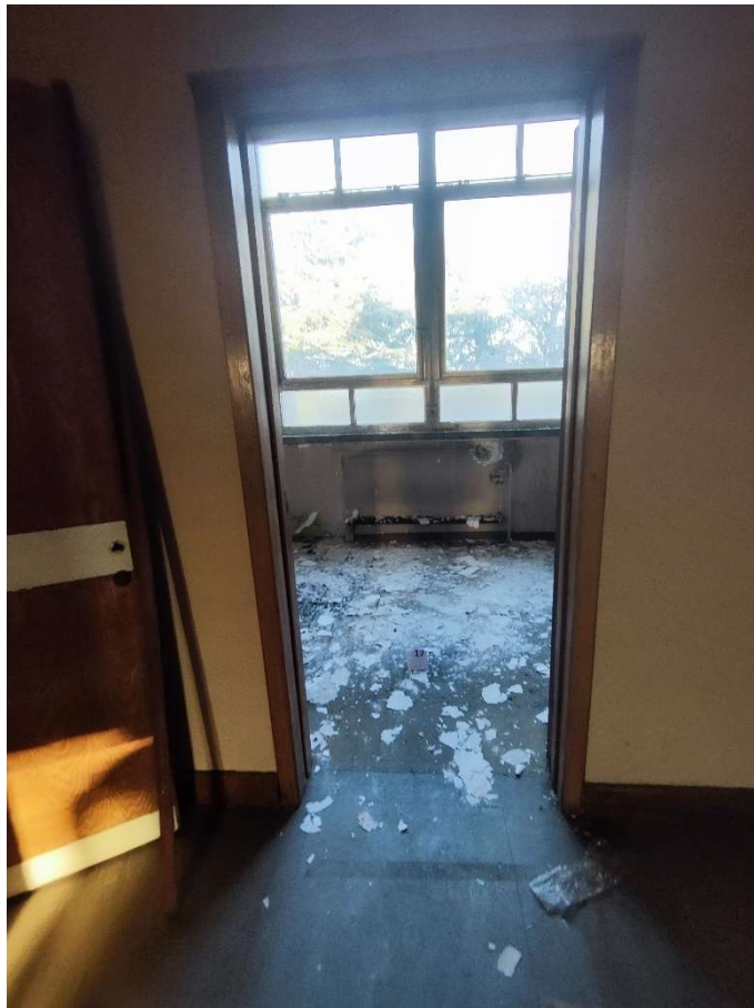
Foto n. 35 – Ingresso ufficio (sub. 757)
