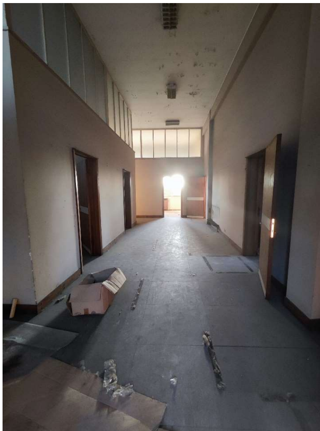
Foto n. 29 – Corridoio piano secondo (sub. 756)
