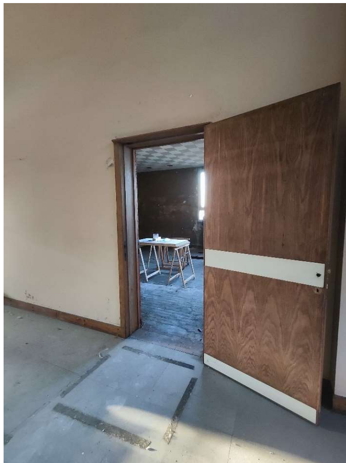
Foto n. 37 – Ingresso ufficio (sub. 758)
