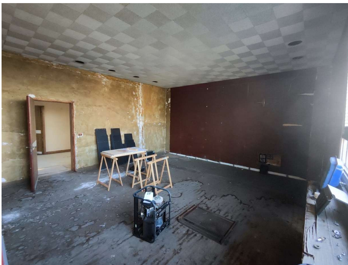
Foto n. 38 – Particolare ufficio (sub 758)
