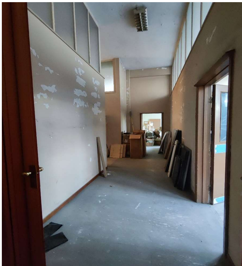
Foto n. 6 – Corridoio piano primo (sub. 756)
