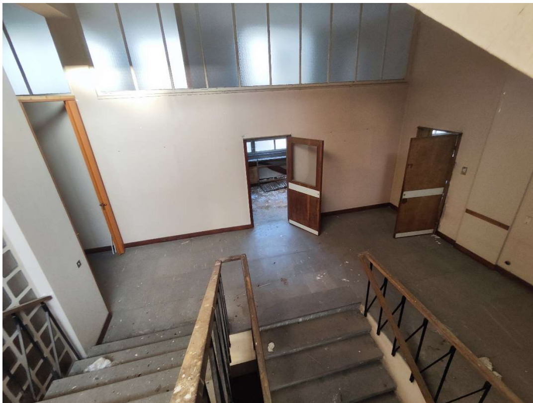
Foto n. 5 – Pianerottolo e ingresso al piano secondo
