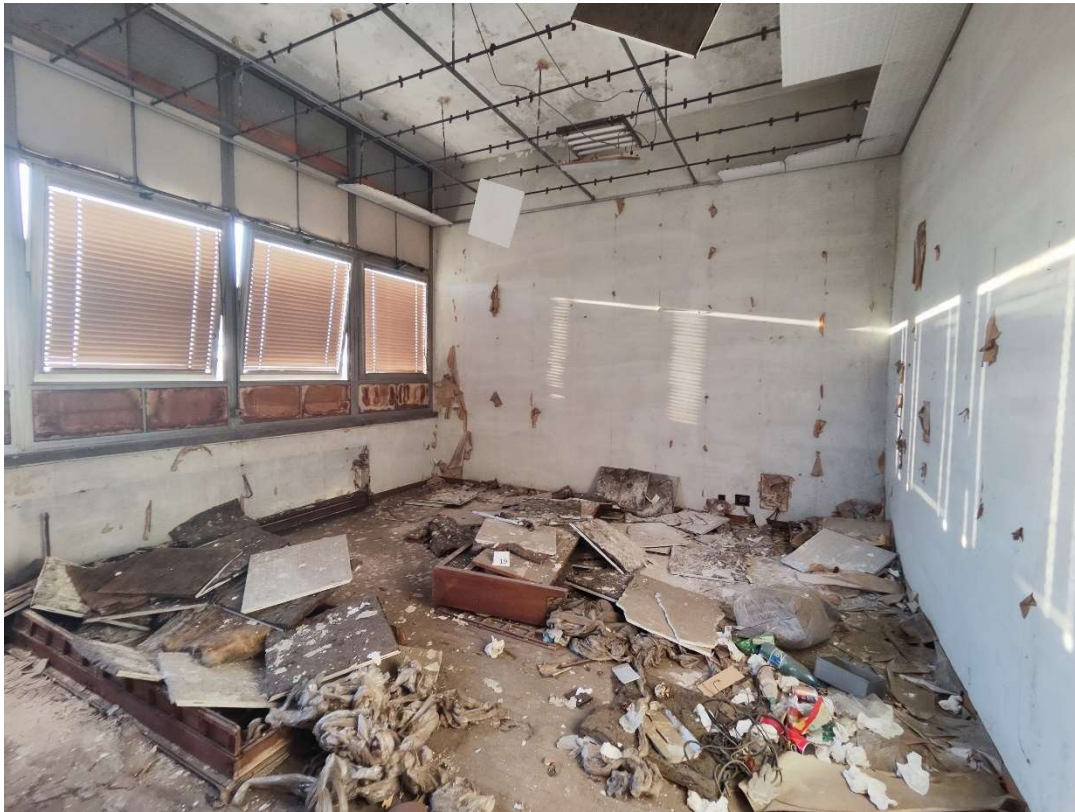
Foto n. 40 – Particolare ufficio (sub 759)
