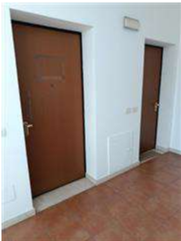
pianerottolo vano scala ascensore comune
