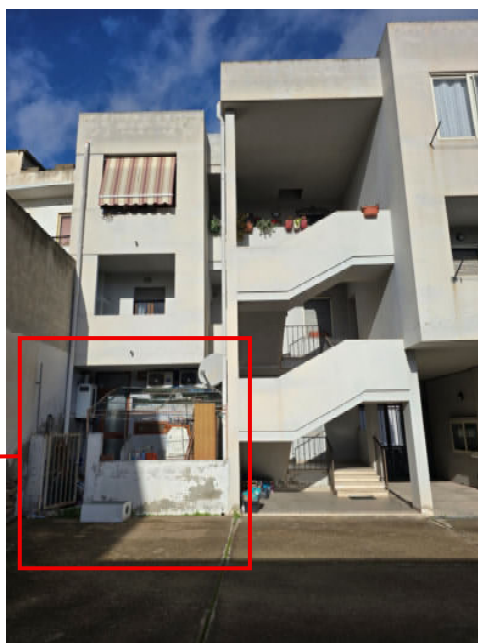
FOTO 15 - CORTILE/VERANDA SUL RETRO
