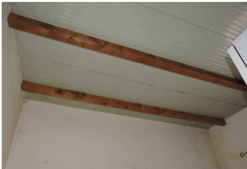
Veduta interna della seconda cameretta. Particolare della struttura di copertura.
