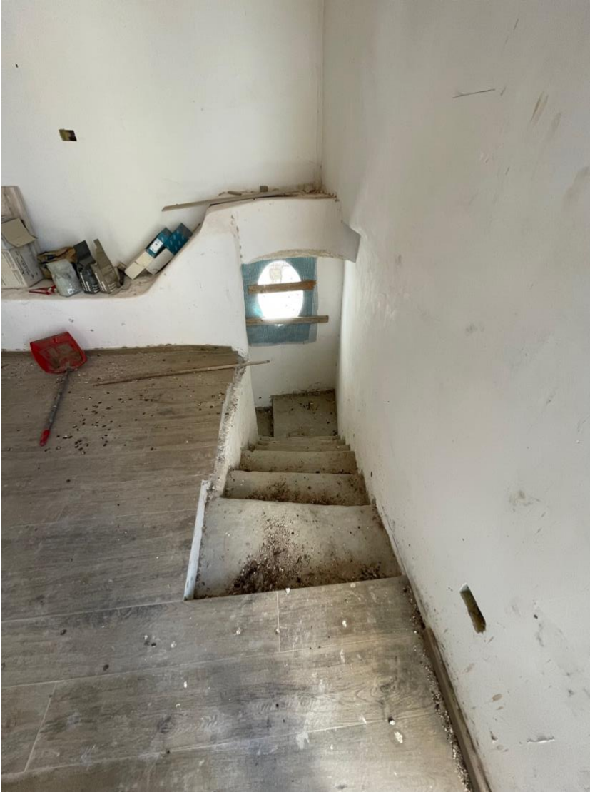
Accesso al piano primo
