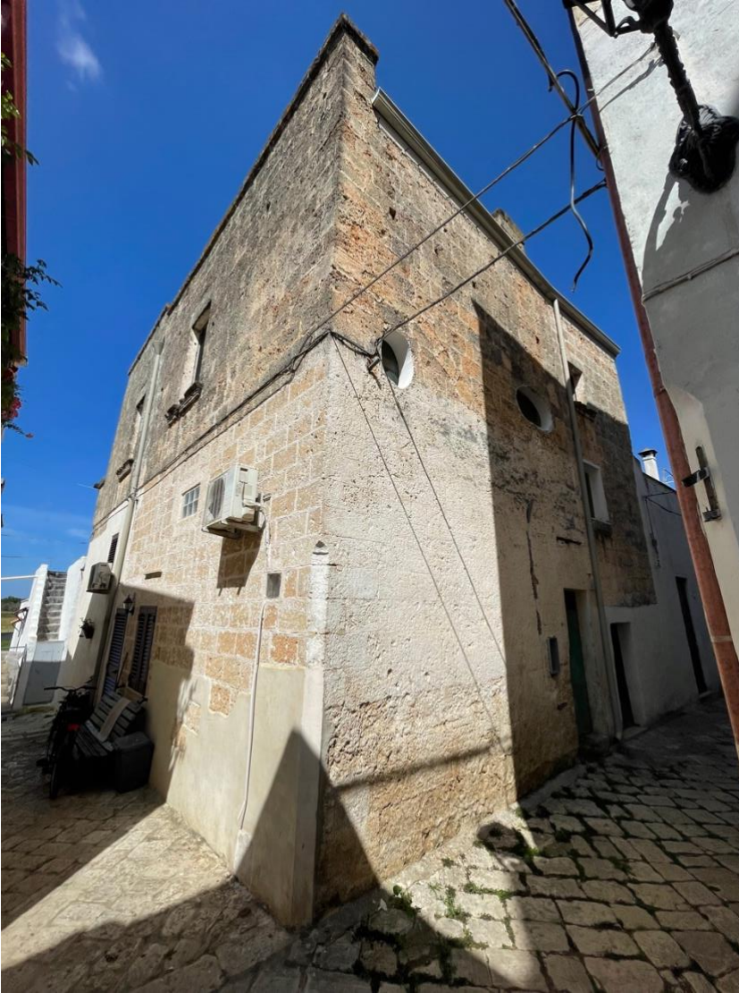
Abitazione al piano primo
