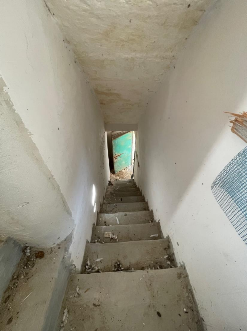
Scala di accesso
