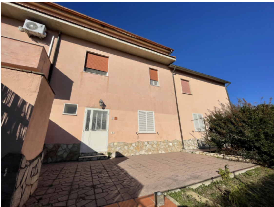
Foto N. 2: vista verso il lato sud ovest del fabbricato, in primo piano la portafinestra della camera
