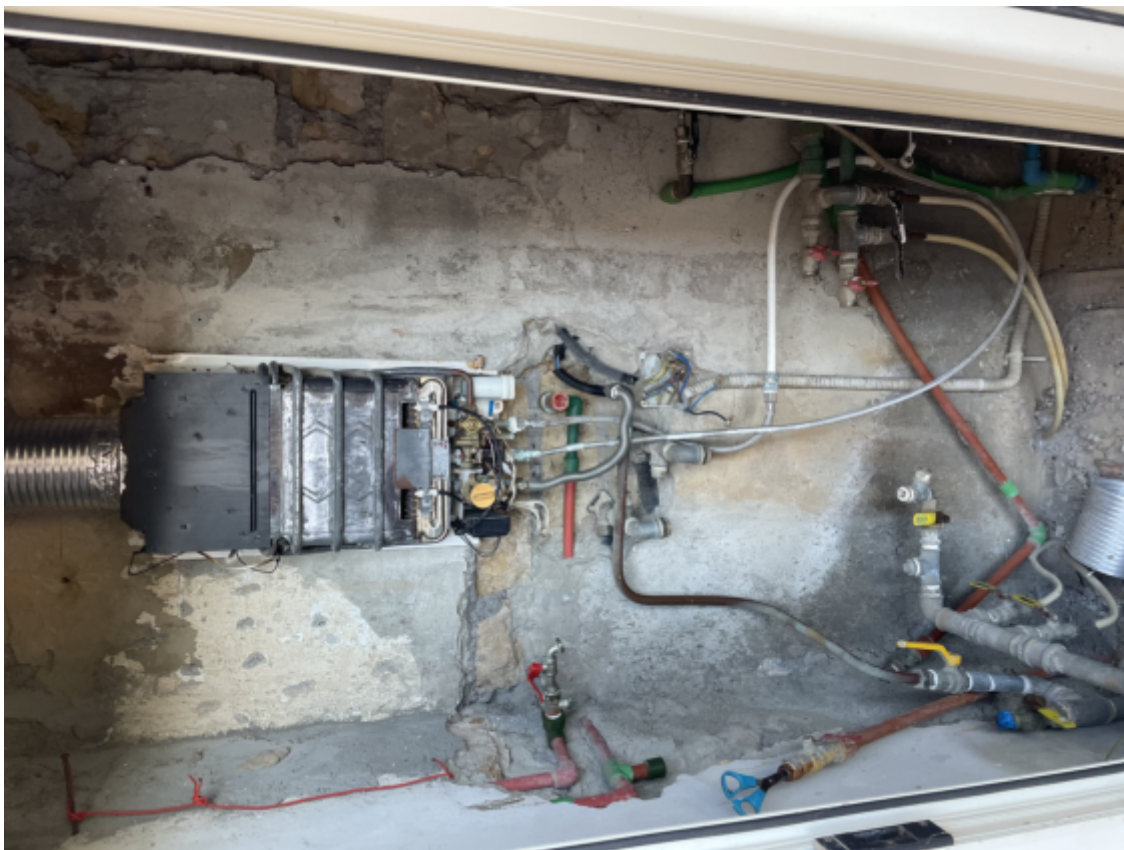
Foto N. 8: Particolare verso la zona dove si trovava la caldaia
