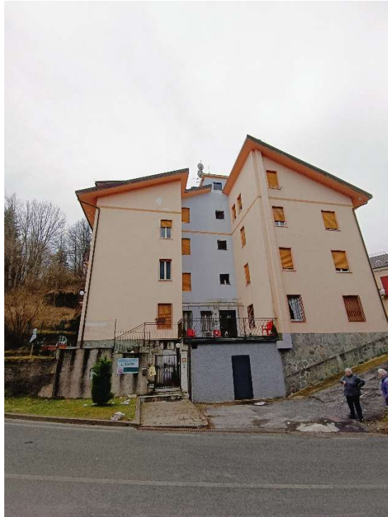
Vista Esterna lungo la strada statale
