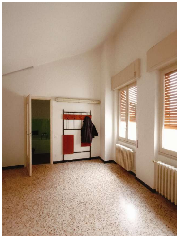
Un locale di servizio nel locale sottotetto
