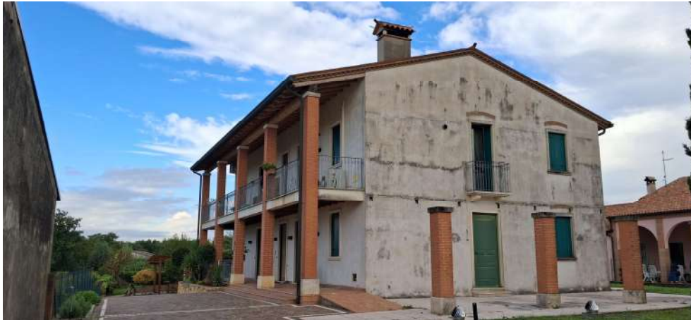
Figura 10. prospetto SUD-EST edificio plurifamiliare
