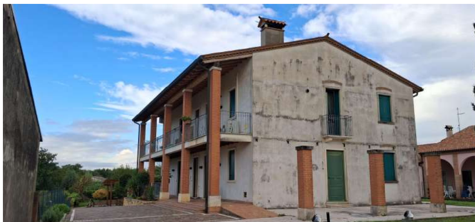
Figura 5 – prospetto SUD-EST edificio plurifamiliare
