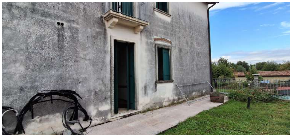
Figura 9 - P.Ila 850 sub. 17 appartamento al PT prospetto NORD
