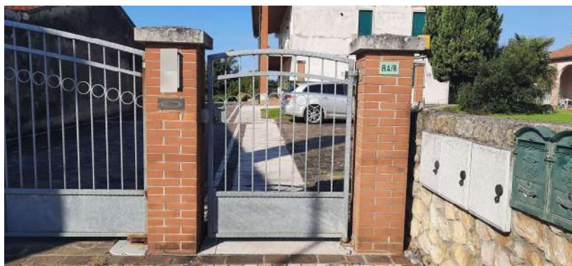
Figura 2 - accesso pedonale e carroia al civico n. 8
