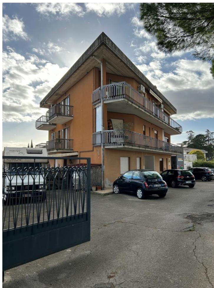
Foto n. 2_Vista frontale/laterale edificio
