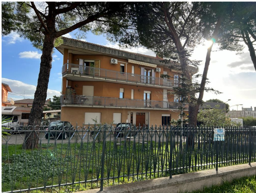
Foto n. 1_Vista frontale edificio
