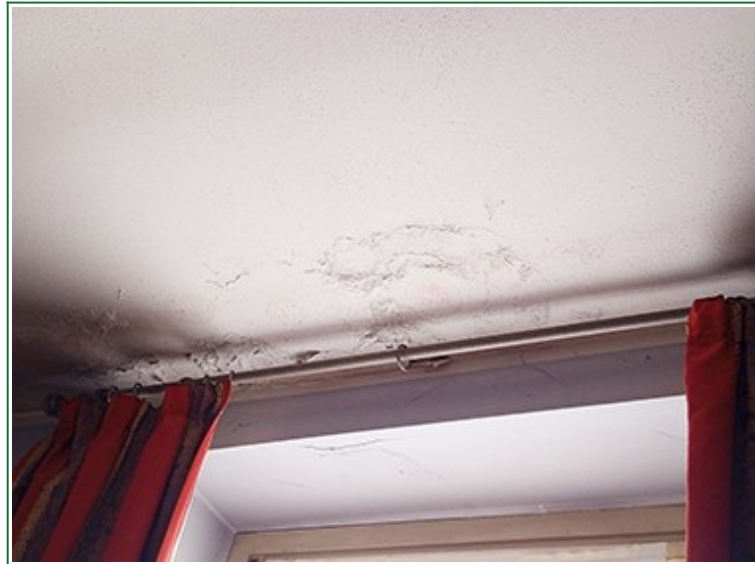
Soffitto della camera a piano primo
