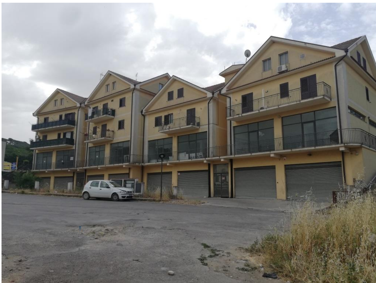
Foto 2 – Prospetto nord del complesso residenziale in cui ricade l'alloggio pignorato
