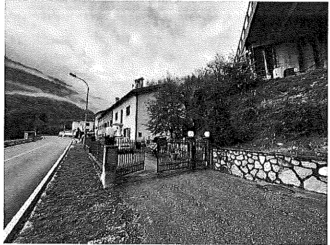
foto 2 vista dagli ingressi pedonale e carroia
