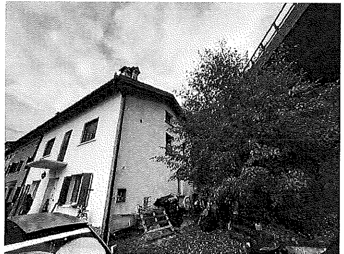
foto 4 vista da sud
