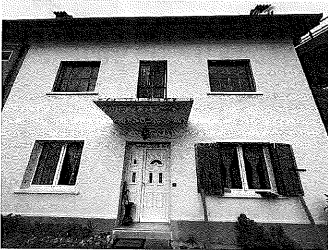
foto 3 vista da sud/ovest – ingresso al PT
