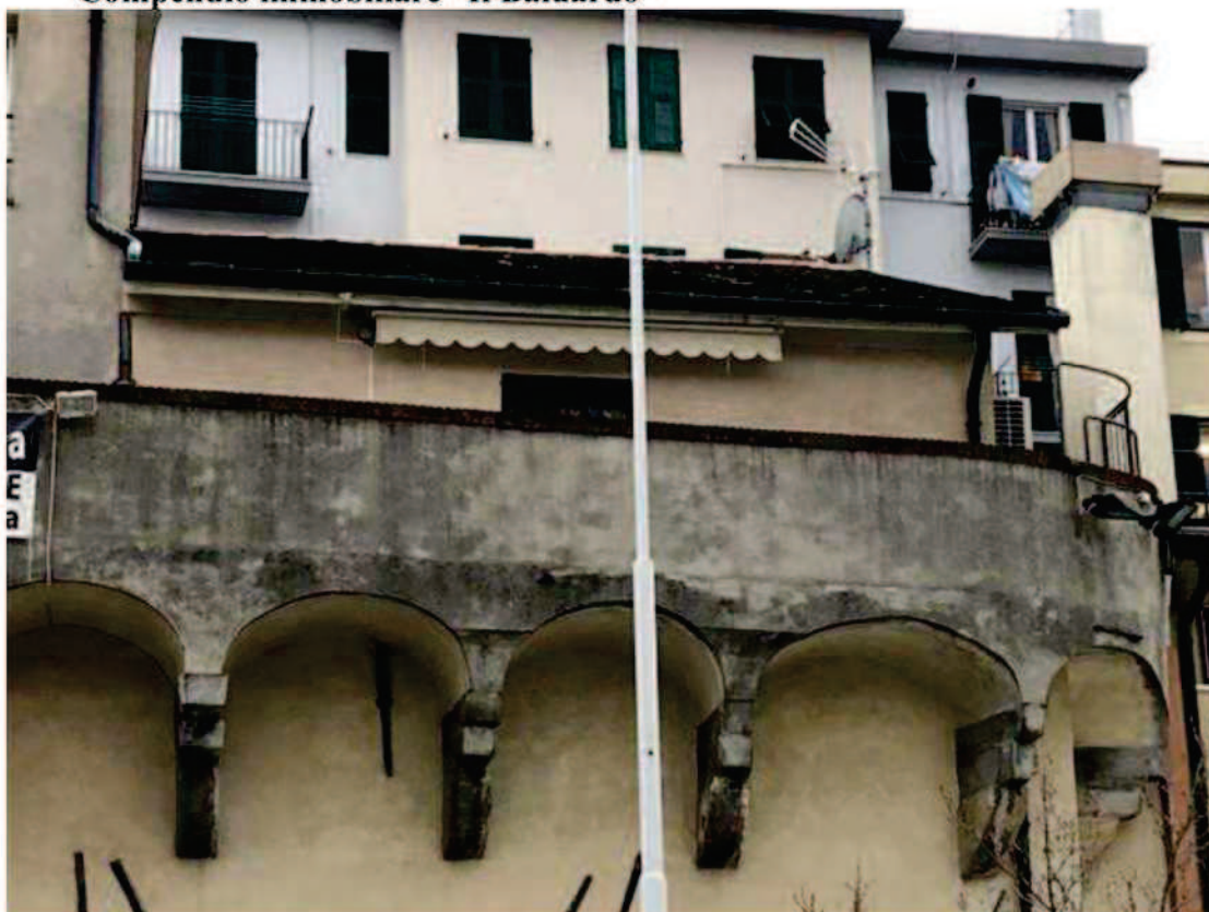
Compendio immobiliare "Il Baluardo"
