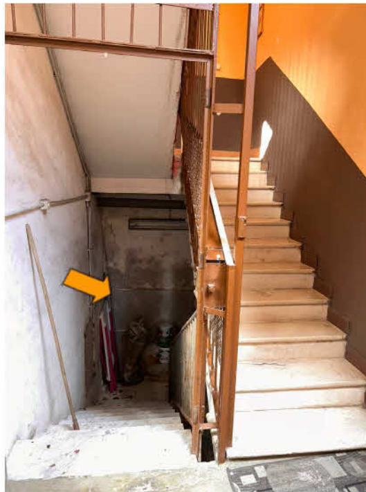
Accesso al bene al PS1 da vano scala
