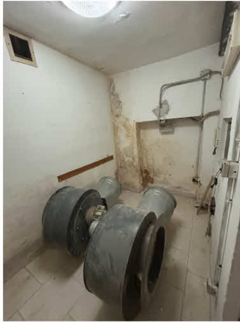
Particolare dell'ambiente adiacente l'ingresso al bene
