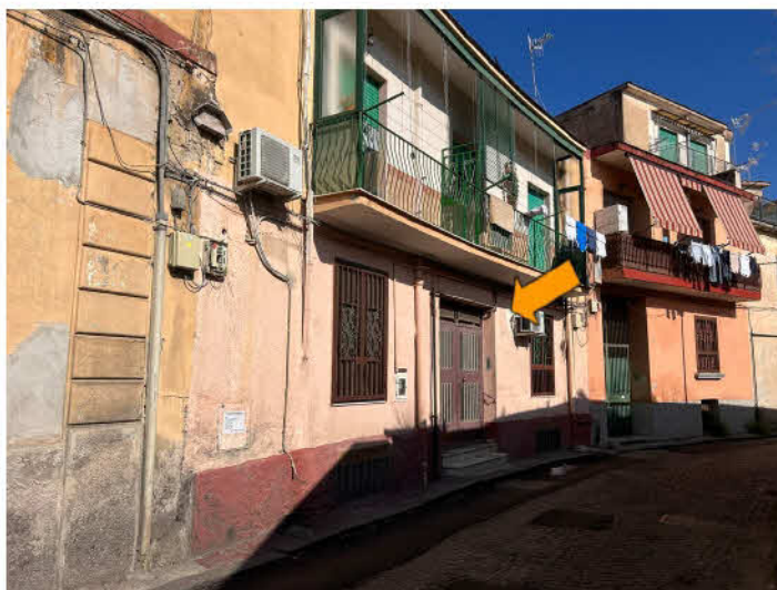
Veduta esterna del fabbricato da Vicoletto detto Improta
