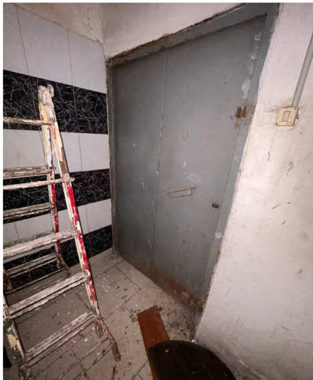
FOTO 6 Porta d'accesso all'u.i. pignorata al PS1 - SUB 101
