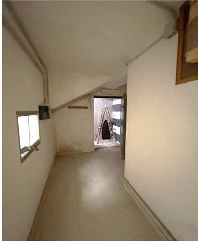
FOTO 7 Locale deposito al PS1 - SUB 101: ingresso
