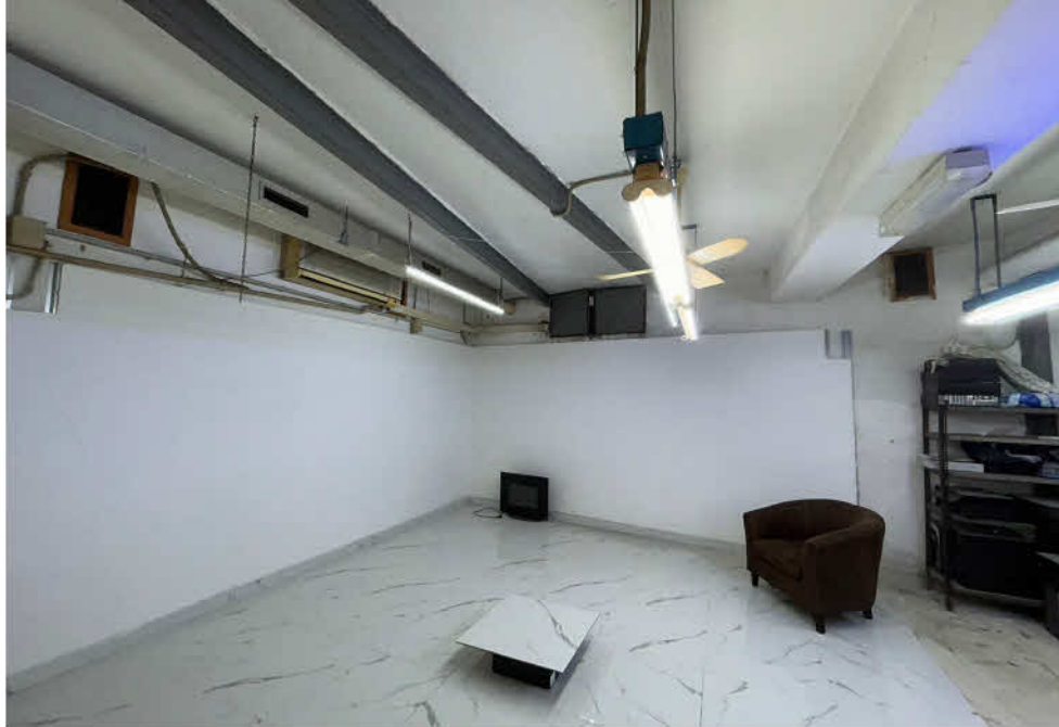
FOTO 11 Locale deposito al PS1 - SUB 101: ambiente principale
