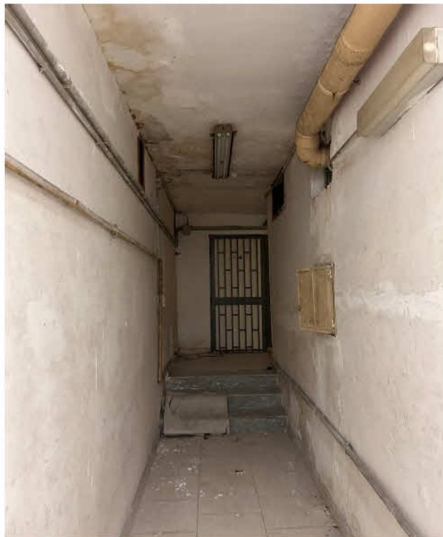
FOTO 8 Locale deposito al PS1 - SUB 101: disimpegno
