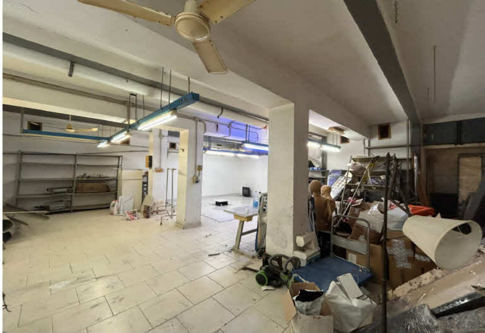
FOTO 9 Locale deposito al PS1 - SUB 101: ambiente principale
