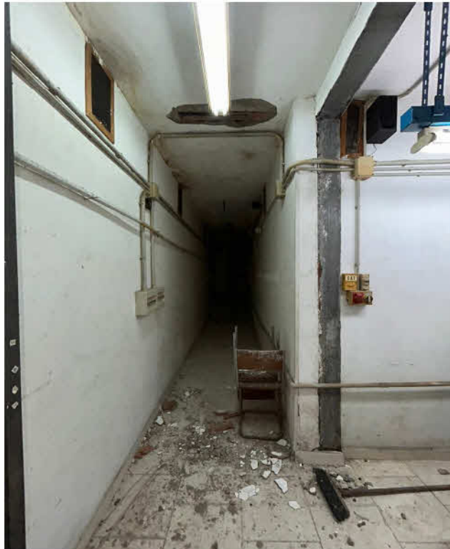
FOTO 14 Locale deposito al PS1 - SUB 101: disimpegno
