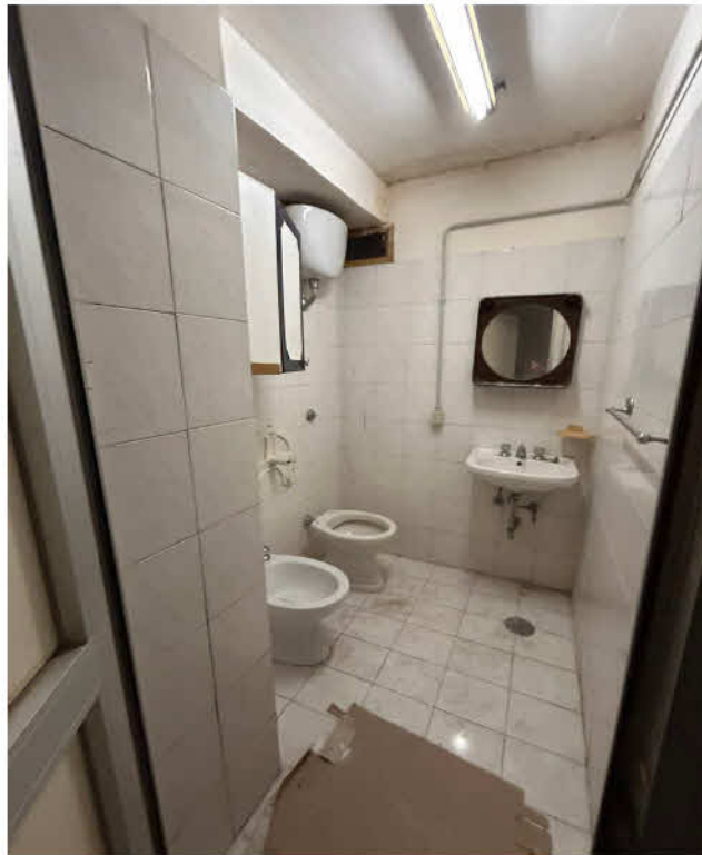
FOTO 16 Locale deposito al PS1 - SUB 101: bagno n°1
