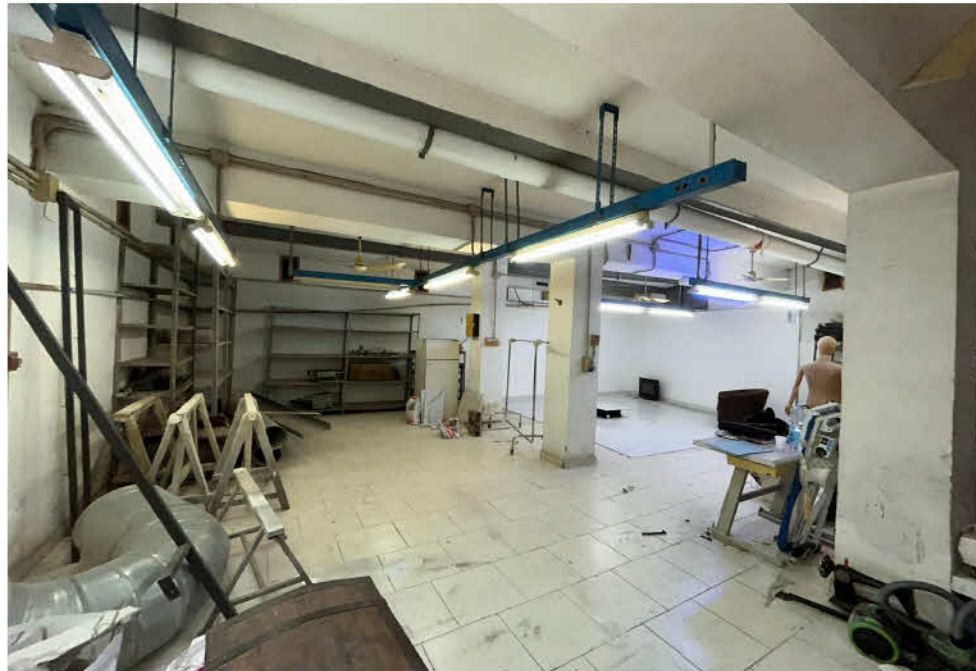
FOTO 10 Locale deposito al PS1 - SUB 101: ambiente principale
