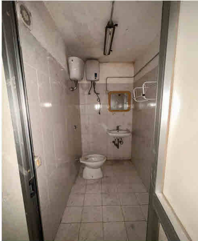
FOTO 17 Locale deposito al PSI - SUB 101: bagno n°2
