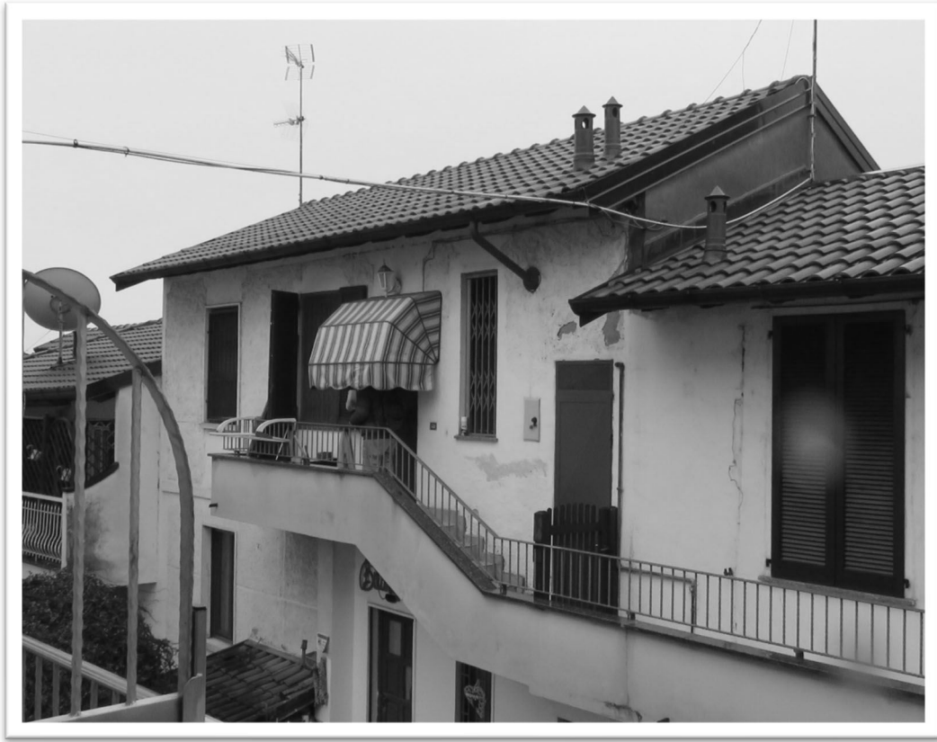
Particolare della zona d'ingresso – 1° piano.
