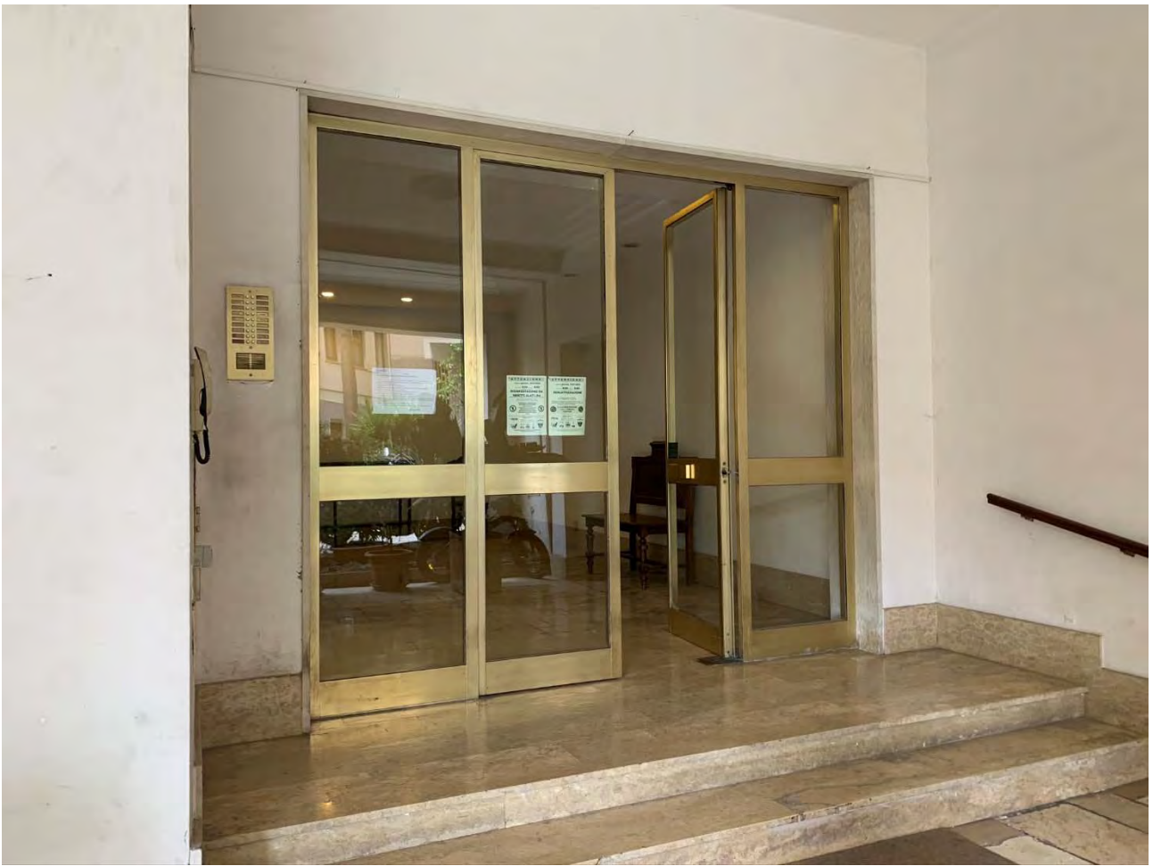
Foto 3 – Vista dell'ingresso al fabbricato F5
