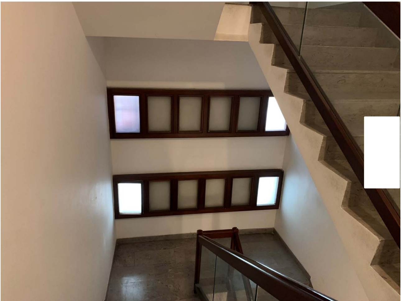
Foto 5 – Particolare del vano scala
