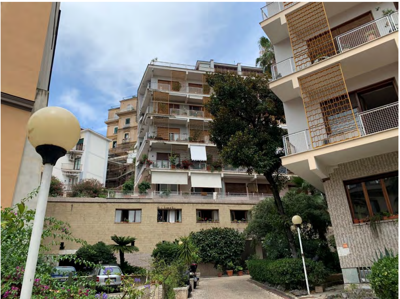
Foto 2 – Vista del fabbricato F5 del Parco Russo-Scarano
