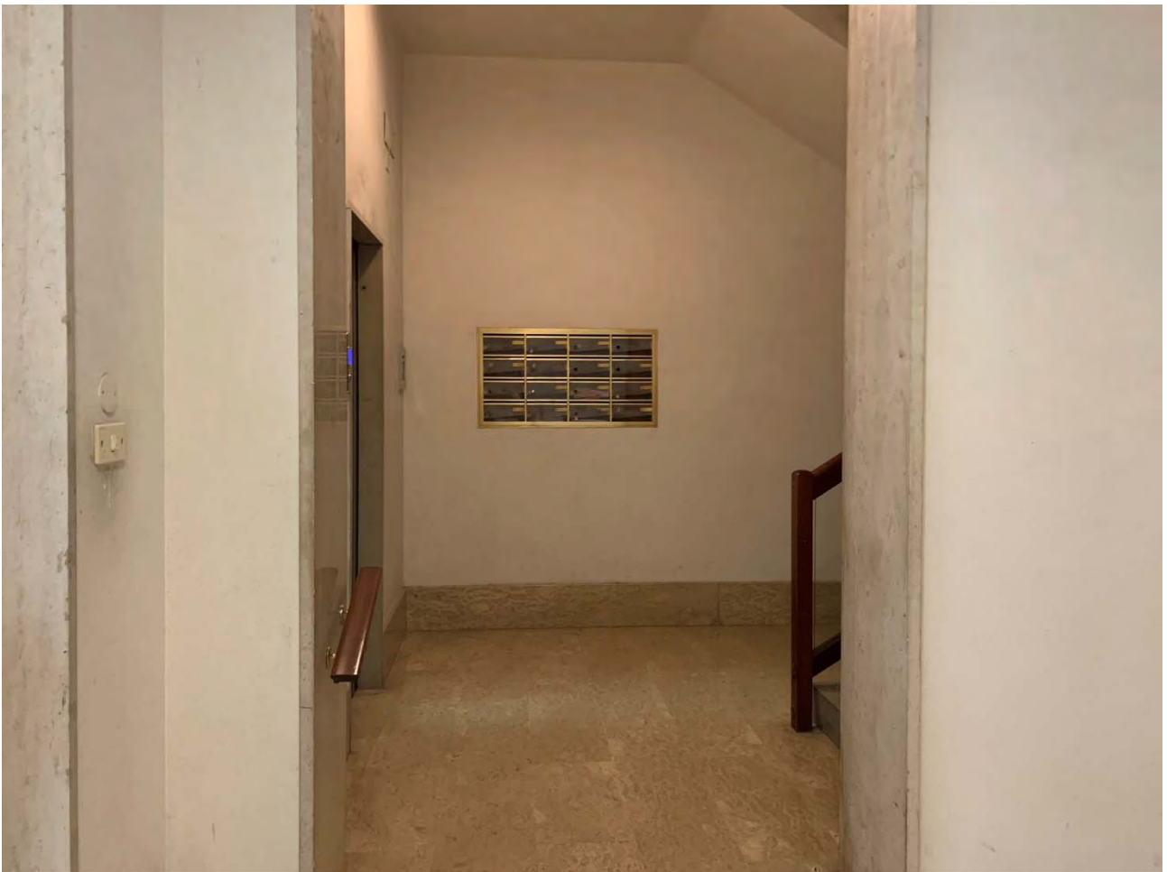
Foto 4 – Particolare dell'androne del fabbricato
