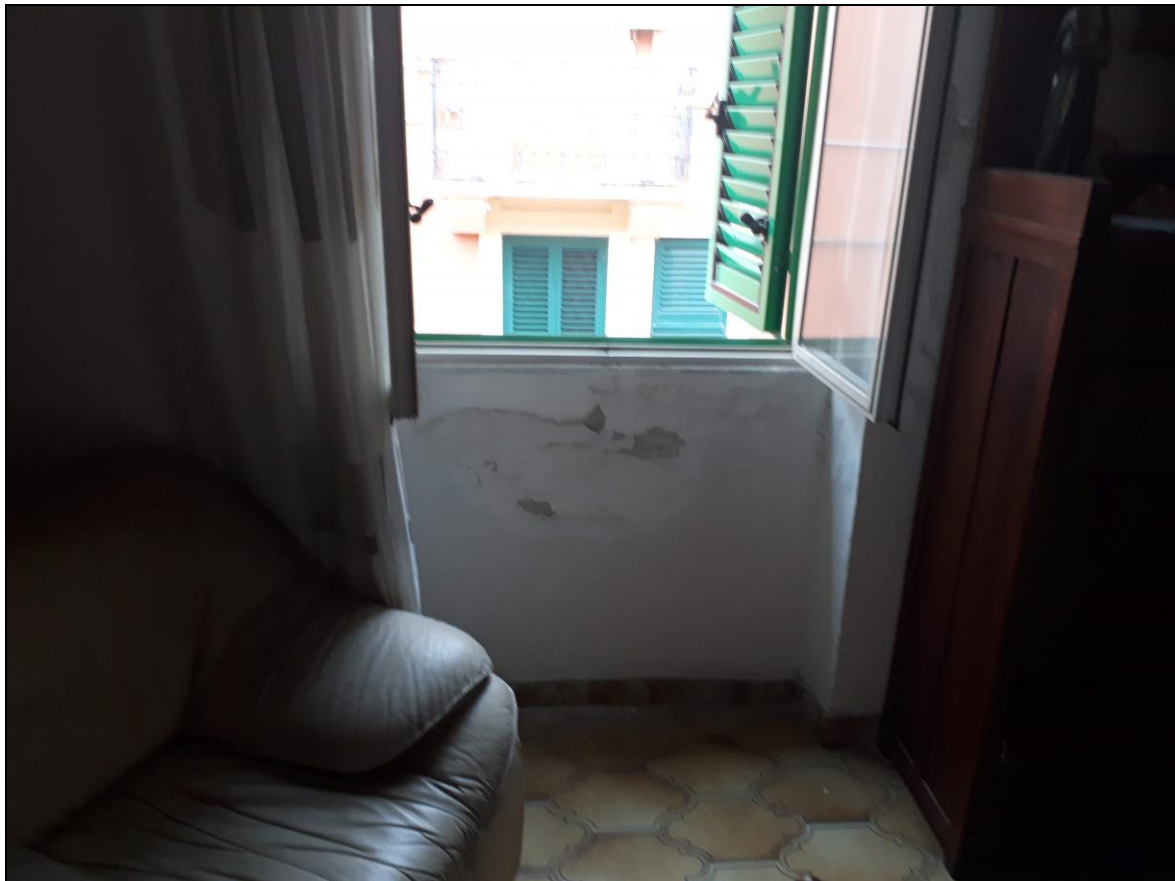
Foto n° 6 – letto 1: particolare parete sotto infisso
