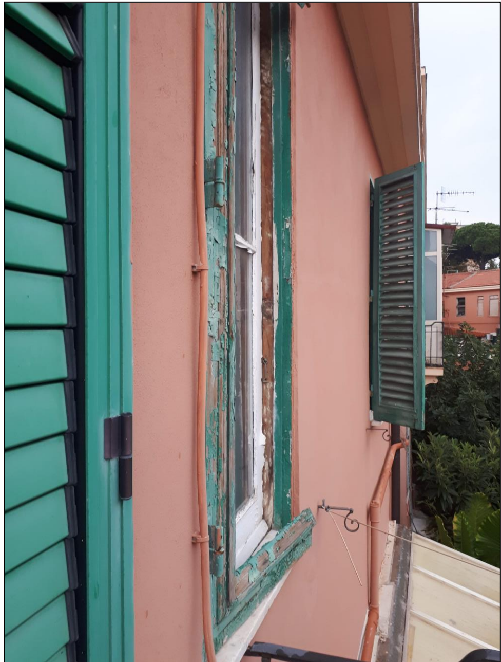
Foto n° 14 – particolare infissi esterni
