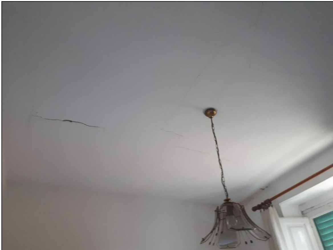
Foto n° 10 – letto 2: particolare soffitto
