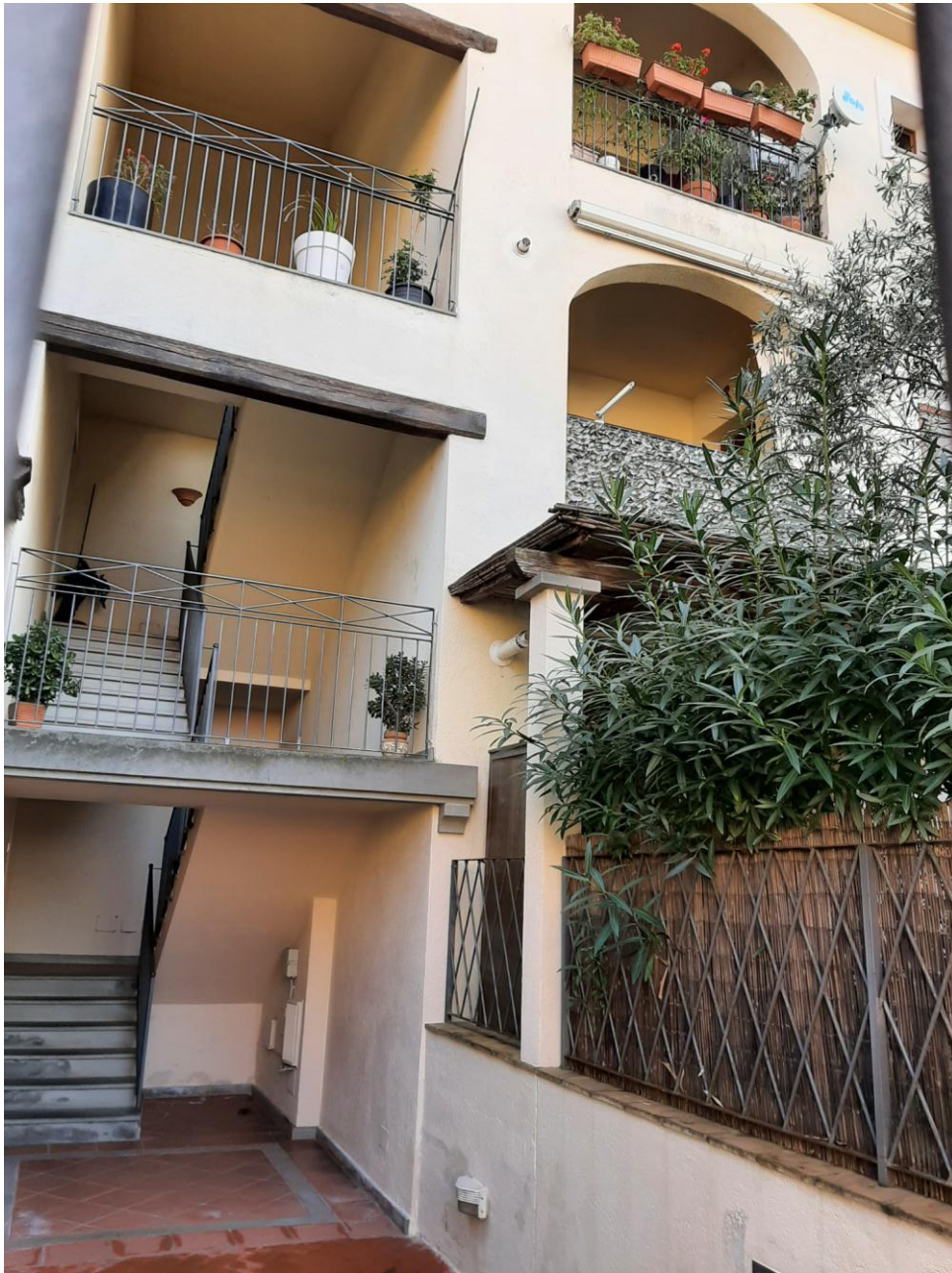
Foto n 2 – Blocco scala di accesso all'appartamento
