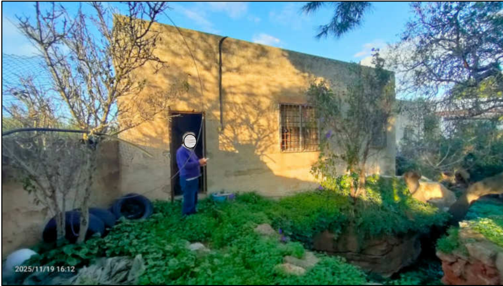
Foto n°22 : vista del ripostiglio esterno
