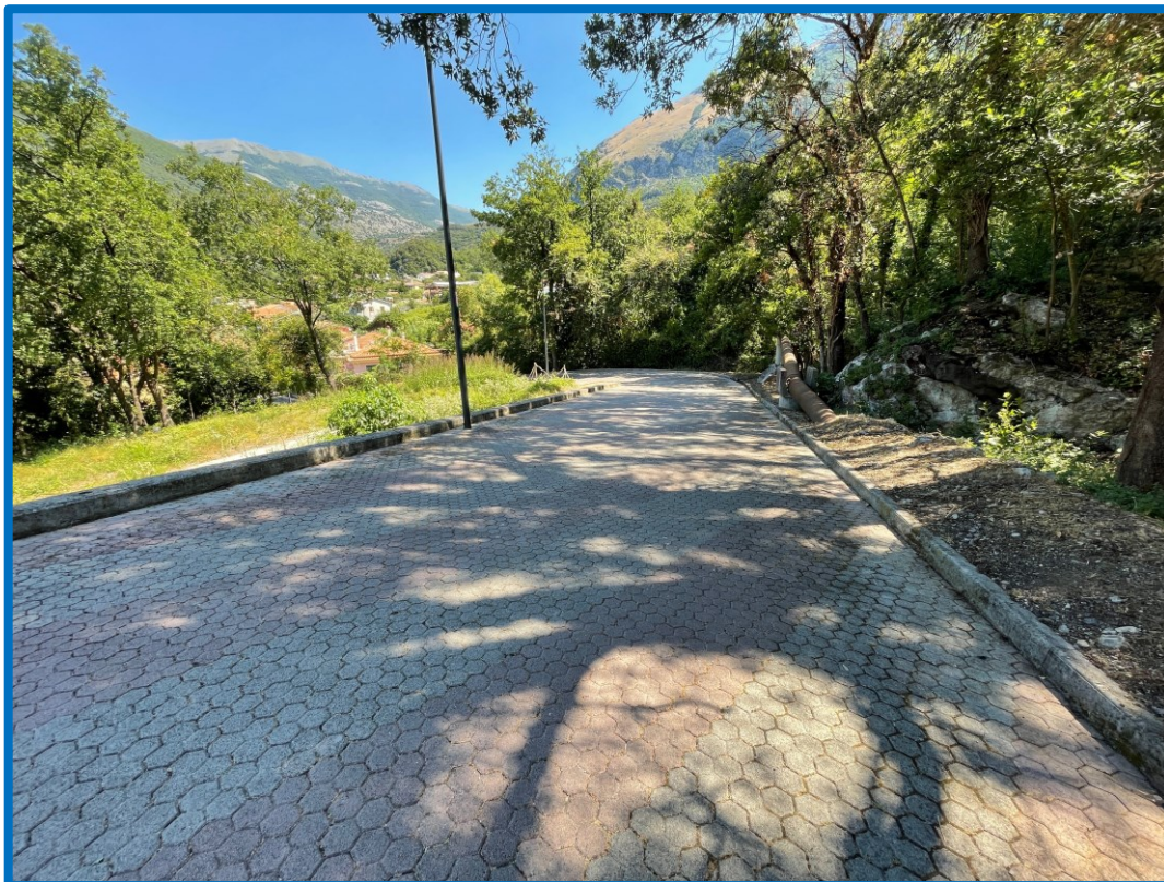
Maratea, località Sorgimpiano foto del 14/07/2022 strada di lottizzazione
