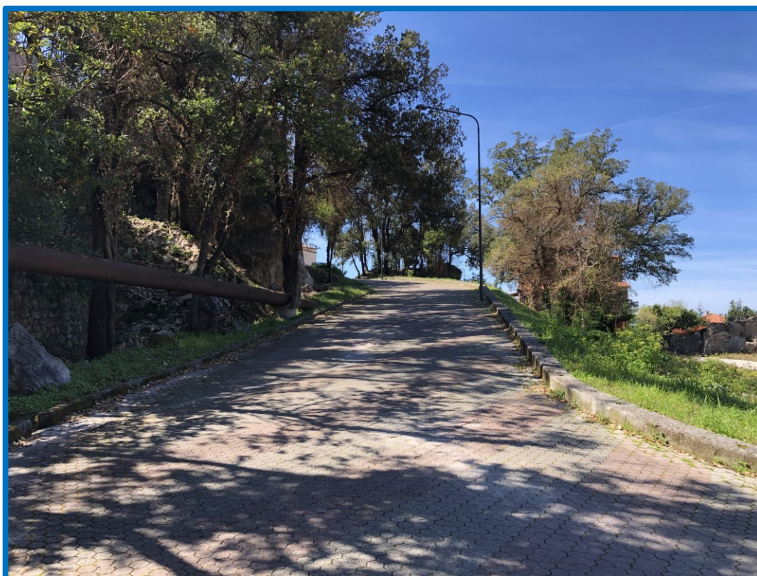
Maratea, località Sorgimpiano foto del 14/07/2022 strada di lottizzazione
