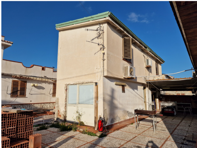
4 | vista del fabbricato 1 da demolire
