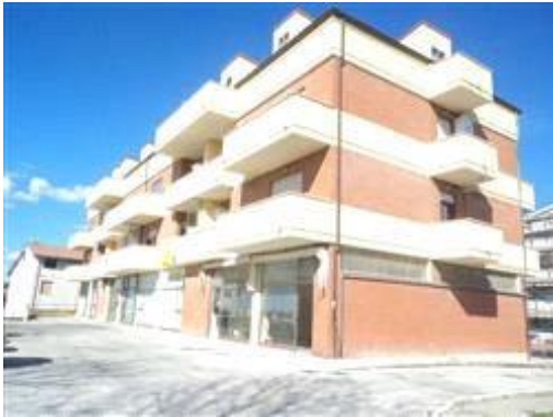
Esterno fabbricato ristrutturato nel 2008 mediante D.I.A. prot. 6591 del 11/04/2008
