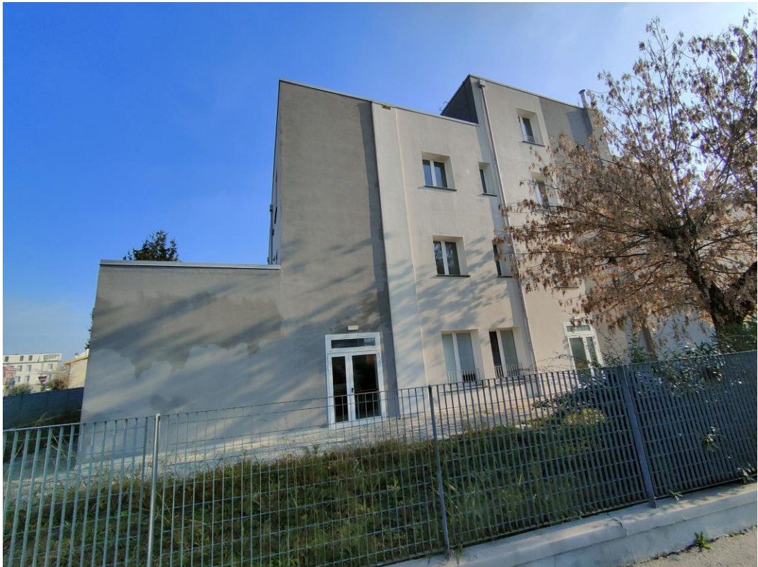
FOTO 5 – Facciata laterale su Via G.Mazzini
