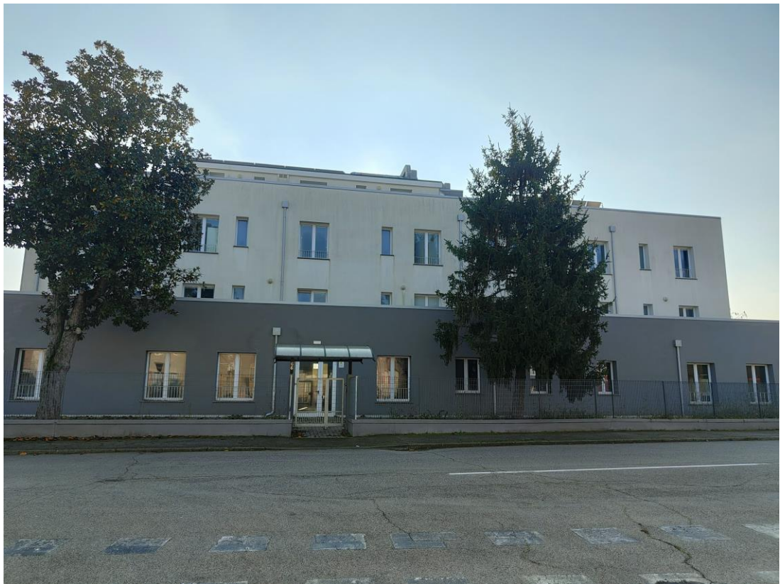
FOTO 1 – Facciata principale su Via G.Garibaldi
