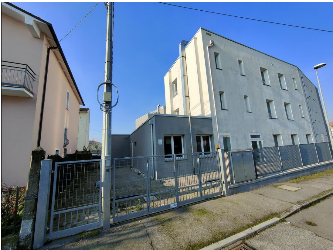
FOTO 4 – Facciata laterale su Via A.Barboni
