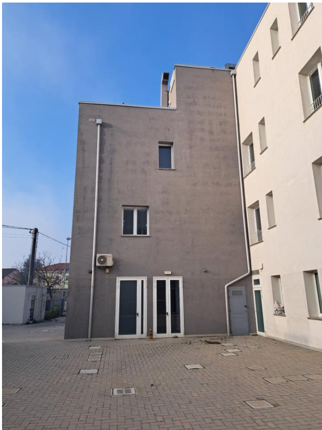
FOTO 10 – Facciata posteriore su cortile
