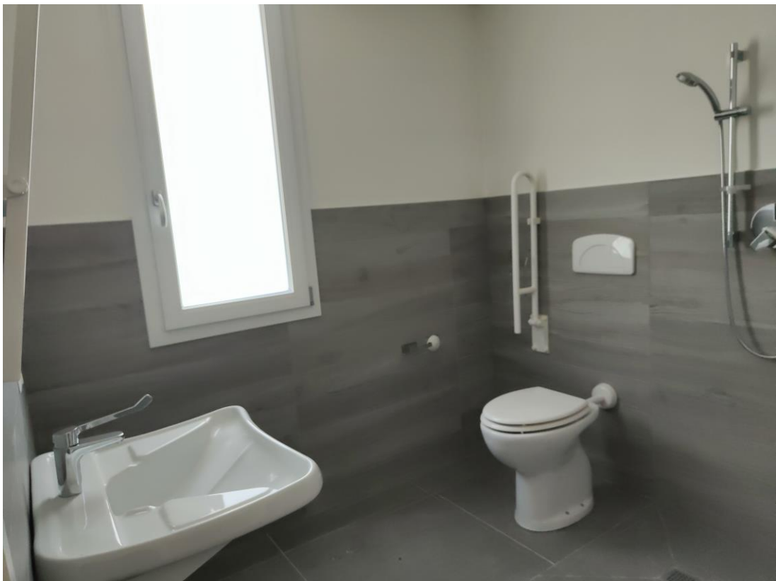
FOTO 16 – Bagno a servizio della camera
