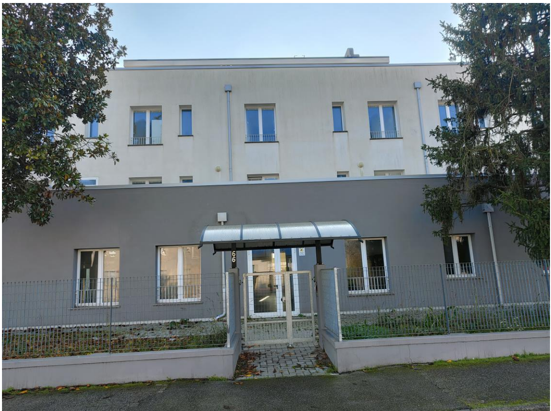
FOTO 2 – Ingresso principale da Via G.Garibaldi
