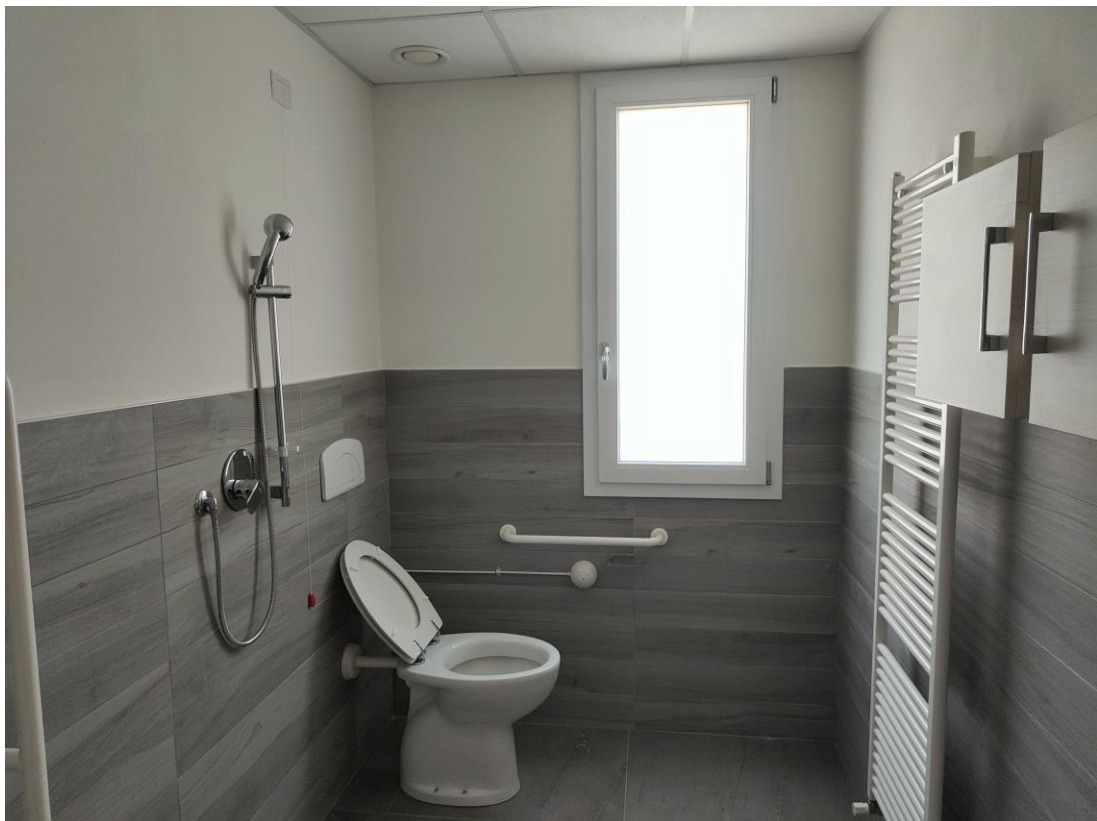
FOTO 8 – Bagno a servizio della camera
