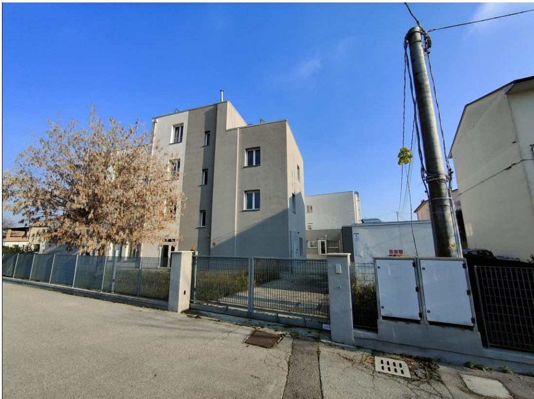
FOTO 6 – Facciata laterale su Via G.Mazzini
