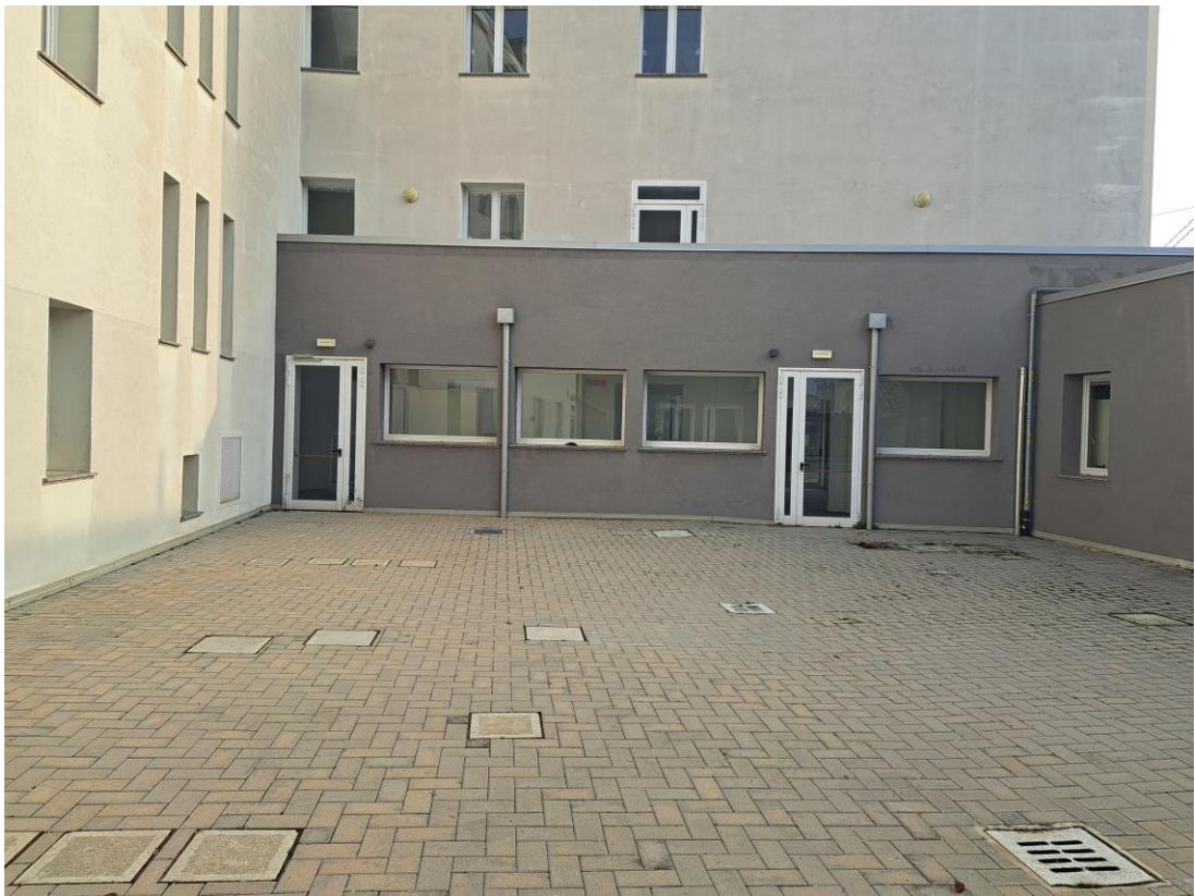
FOTO 9 – Facciata posteriore su cortile
