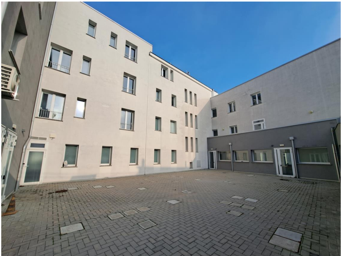
FOTO 7 – Facciata posteriore su cortile
