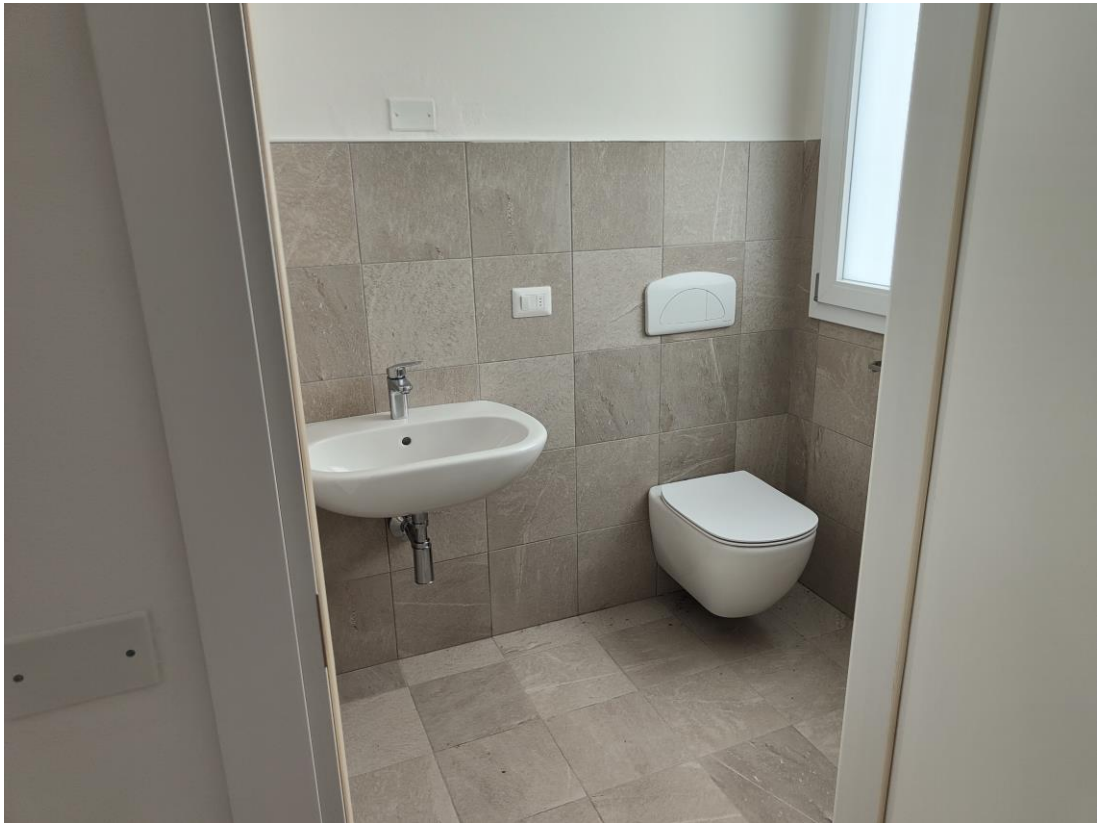
FOTO 11 – Bagno a servizio dello spogliatoio
