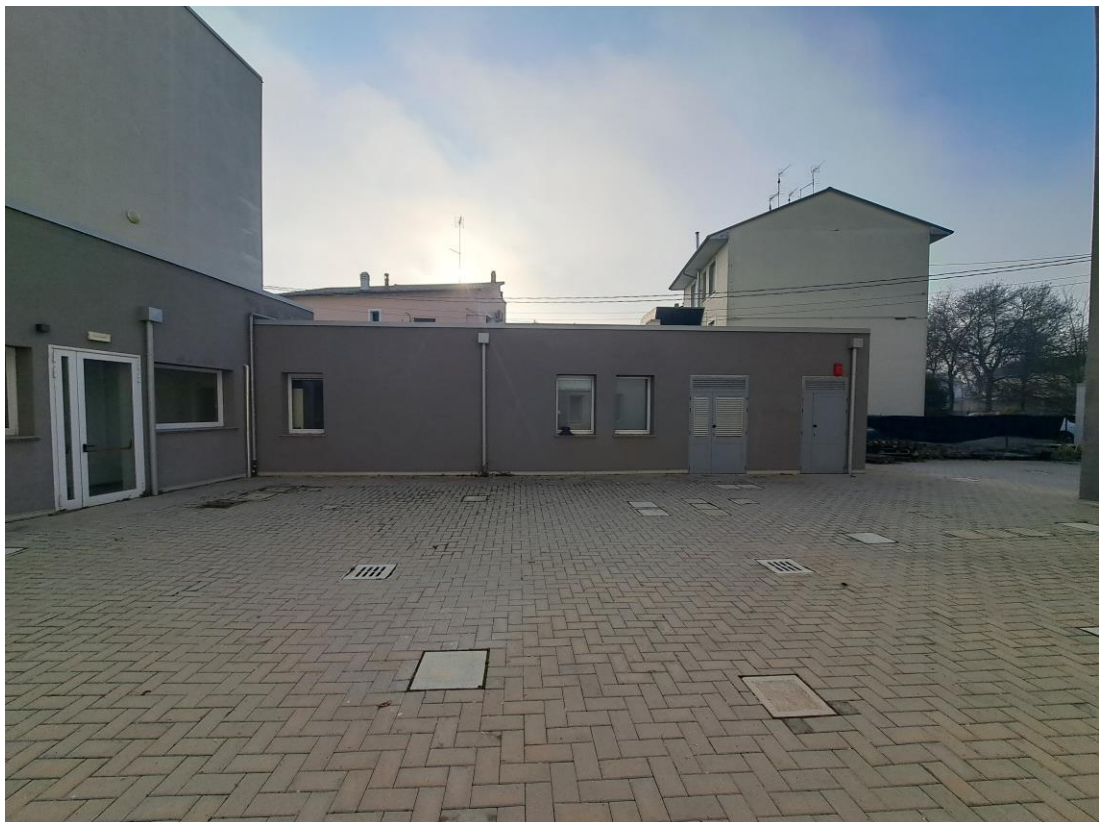
FOTO 8 – Facciata posteriore su cortile
