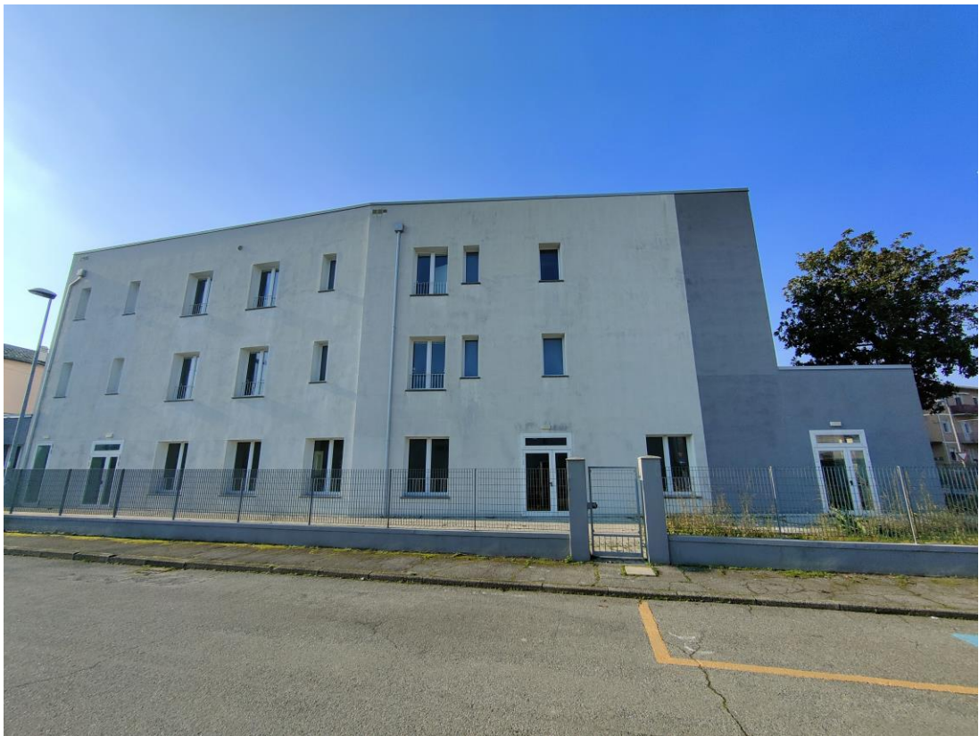
FOTO 3 – Facciata laterale su Via A.Barboni
