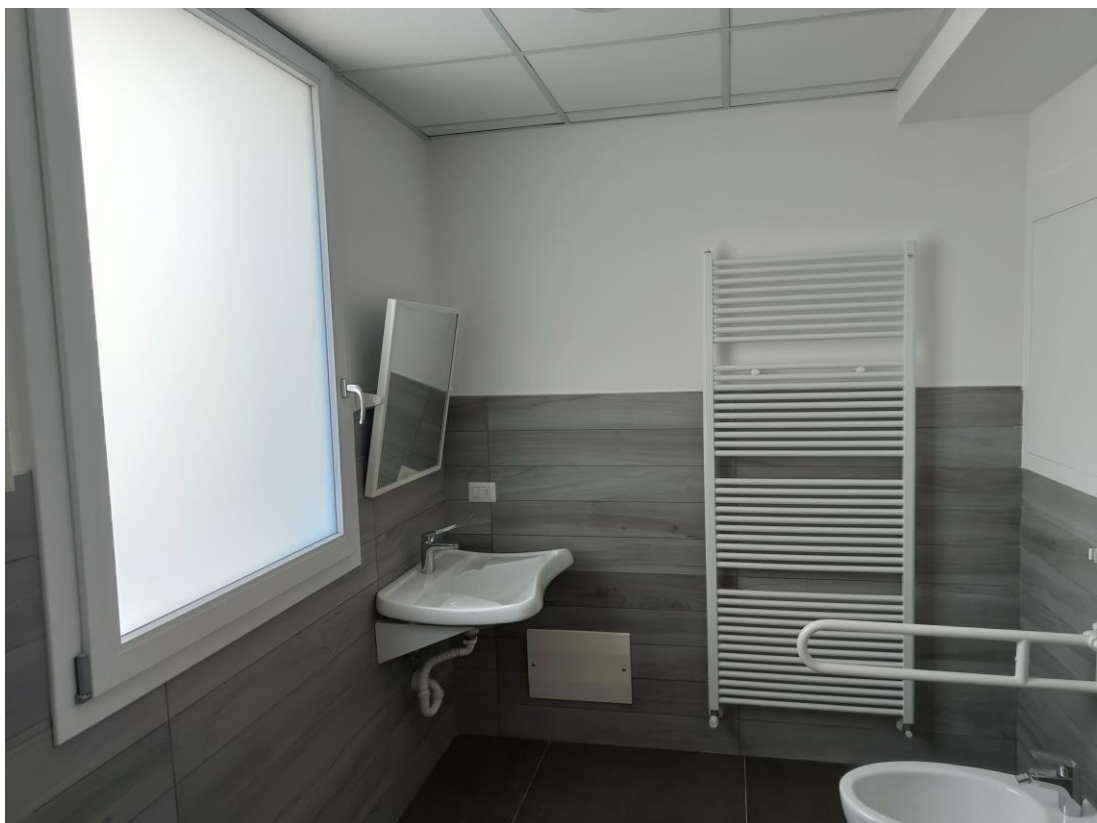
FOTO 6 – Bagno a servizio della camera
