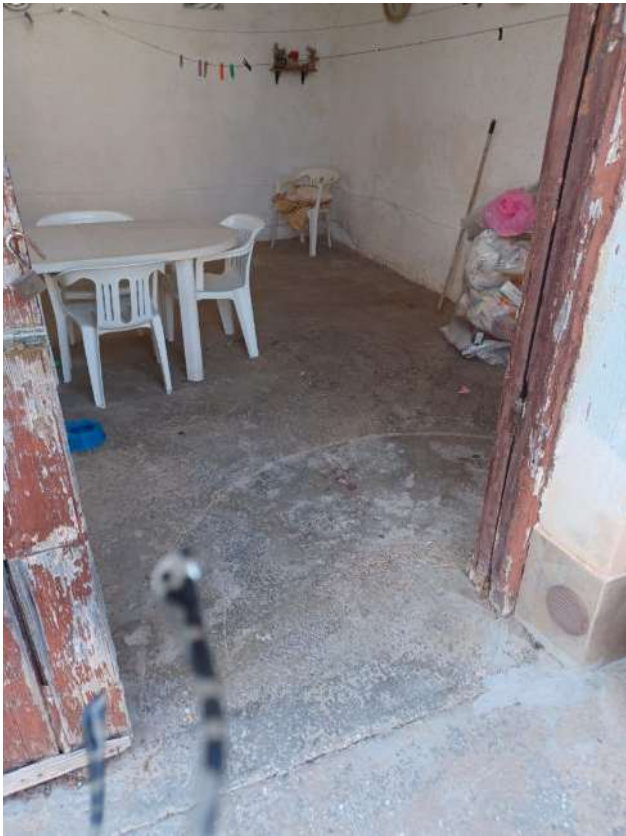
accesso al magazzino 5.a
