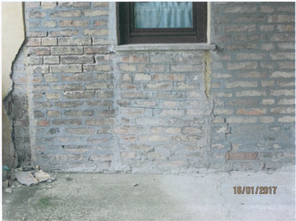
Foto 48- Cedimento Fondale Prospetto Sud-Ovest -Piano Terra
