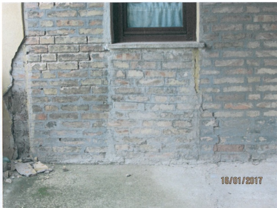
Foto 29.a - Lesioni passanti ad andamento pressochè verticali in corrispondenza di incroci fra muri (Tipo 7) Prospetto Sud-Ovest - Piano Terra - Maschio Murario Garage e Nucleo Originario - Esterno
