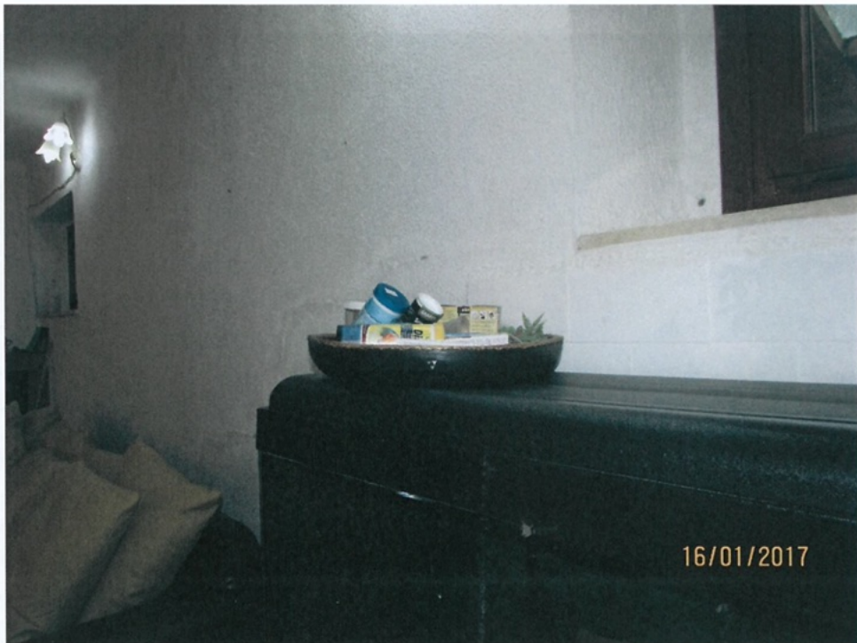
Foto 11.b - Lesioni ad andamento diagonale in elementi verticali (Tipo 3) Piano Terra - Pranzo Soggiorno - Maschio Murario lato Nord-Est Dettaglio
