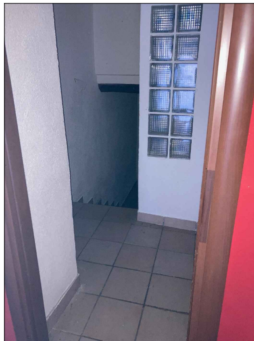
Foto 18 - DISIMPEGNO AL 1P
