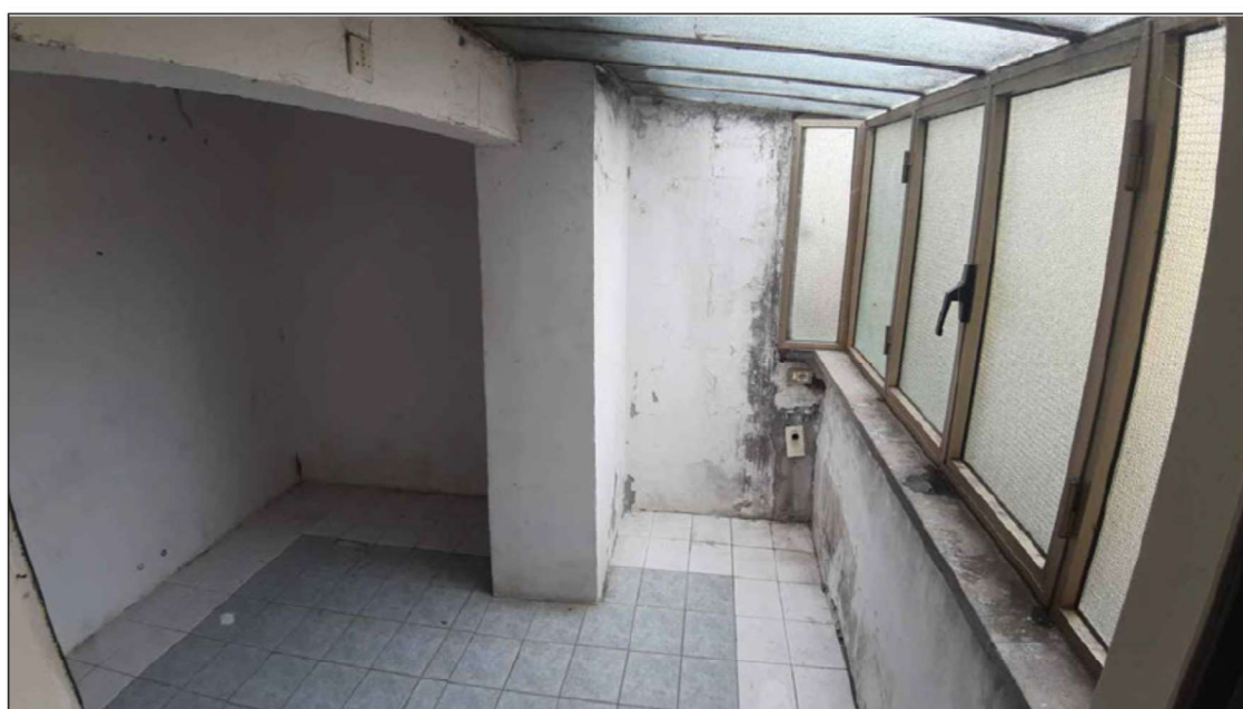
foto 22 - vista della veranda al piano 1°.
