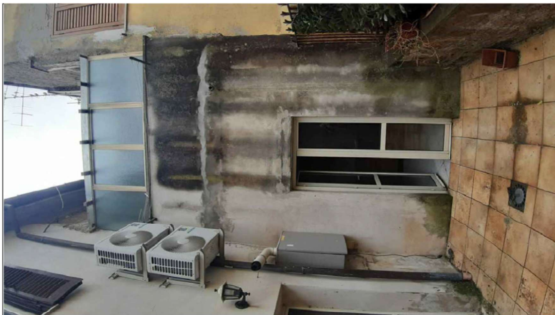
foto 13 - vista della facciata con le infiltrazioni.
