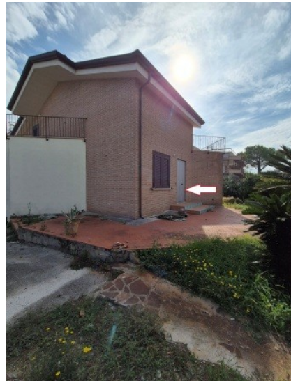
Figura 34 cortile pertinenziale al piano terra
