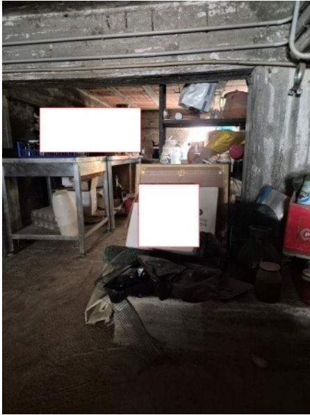
Figura 31 cantinola 1 piano seminterrato
