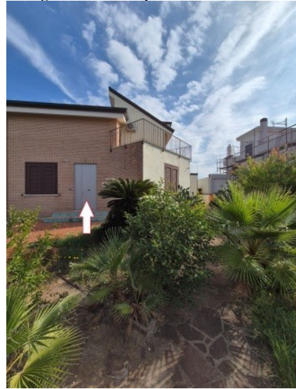
Figura 40 terreno pertinenziale lato sud
