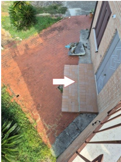
Figura 33 cortile pertinenziale al piano terra
