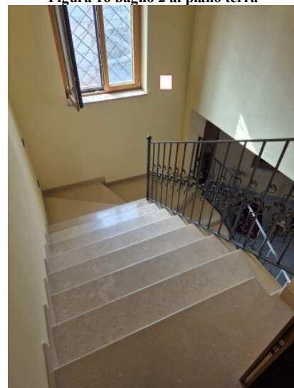
Figura 18 scala interna di collegamento tra il piano terra ed il primo piano
