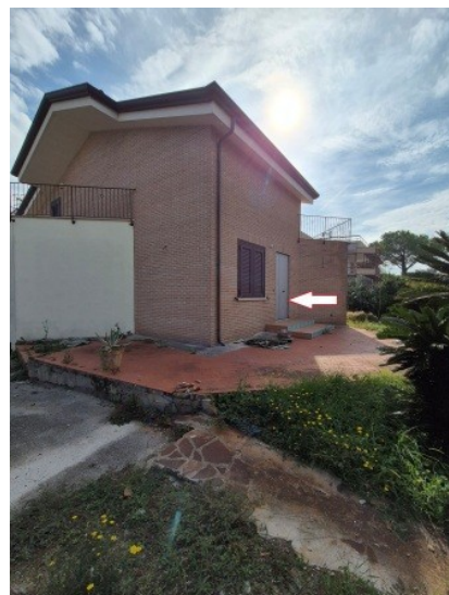
Figura 37 cortile pertinenziale al piano terra
