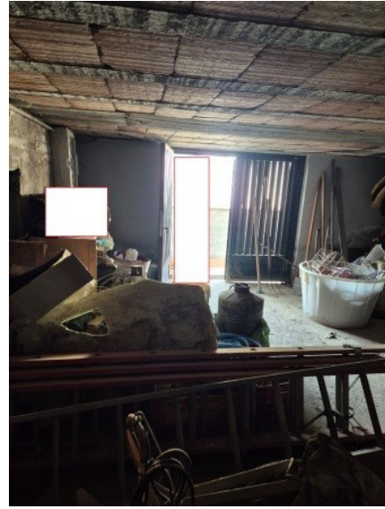
Figura 33 cantinola 2 piano seminterrato
