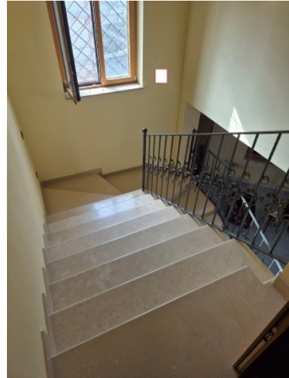
Figura 21 scala interna di collegamento tra il piano terra ed il primo piano
