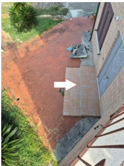
Figura 36 cortile pertinenziale al piano terra
