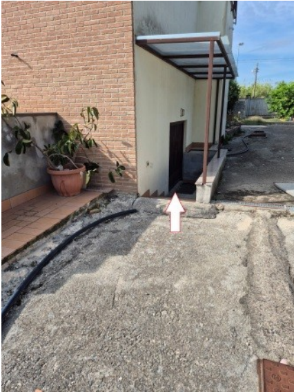
Figura 32 accesso al piano seminterrato dalla scala esterna
