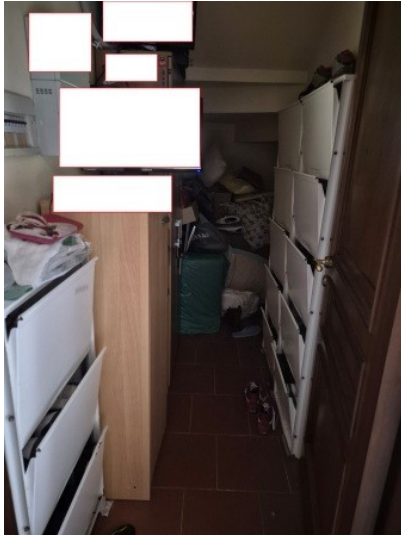
Figura 20 ripostiglio al piano terra
