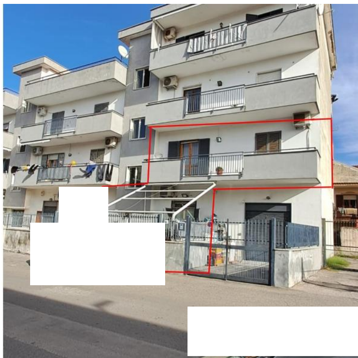
VISTA DEL FABBRICATO CON INDICAZIONE IN ROSSO DEGLI IMMOBILI STAGGITI
