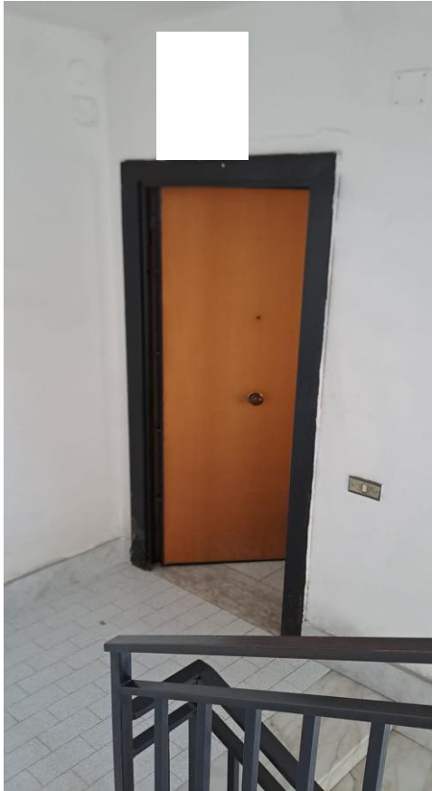
INGRESSO APPARTAMENTO (Primo piano) DAL VANO SCALA
