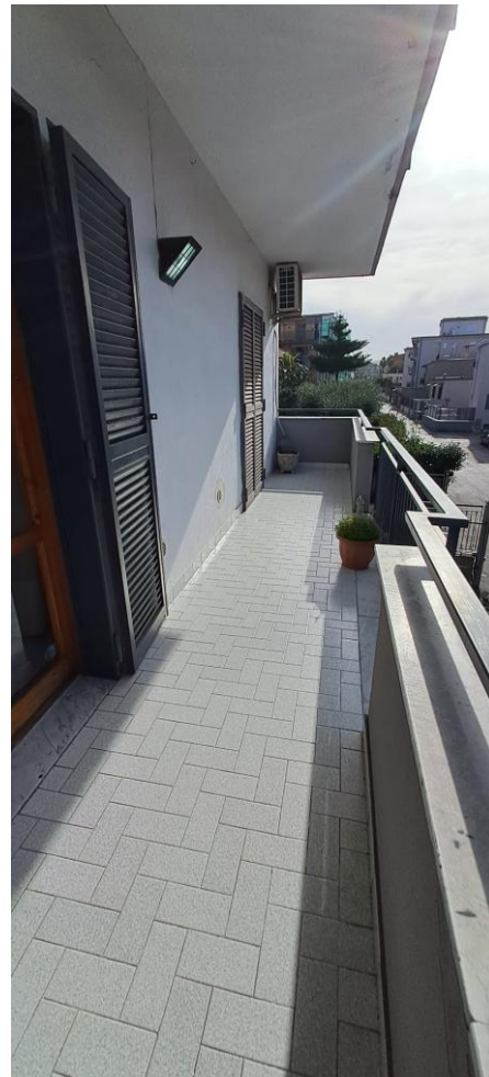
BALCONE (lato OVEST)
